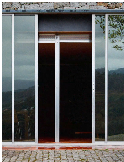
Figura 57. Janela exterior dos espaços comuns
