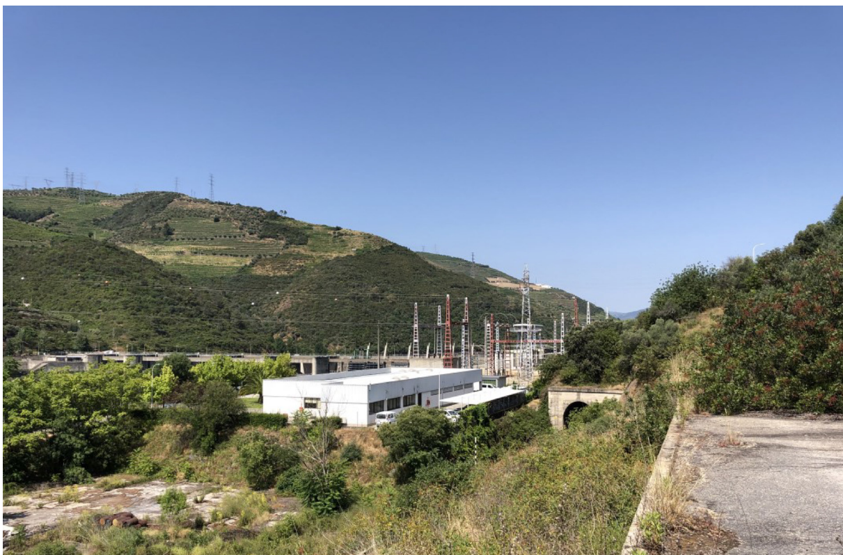
Figura 8. Vista do terreno para a central hidroelétrica (EDP) Imagem do atelier Barbosa & Guimarães
