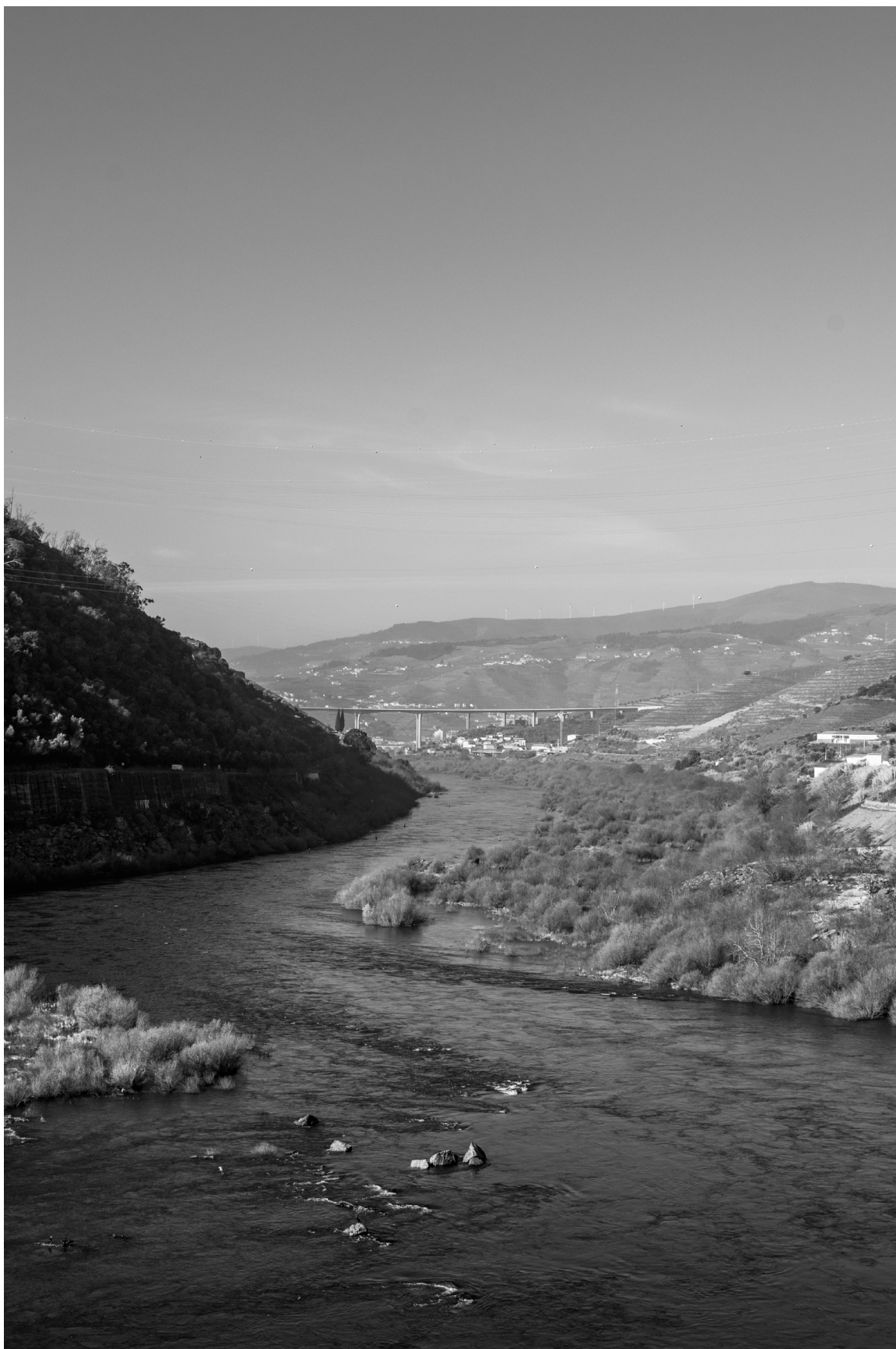
Figura 20. Vista sobre a ponte Miguel Torga (A24). Peso da Régua Imagem do autor
