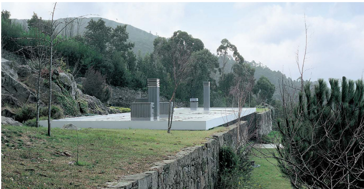
Figura 52. Vista da cobertura da Casa em Moledo
