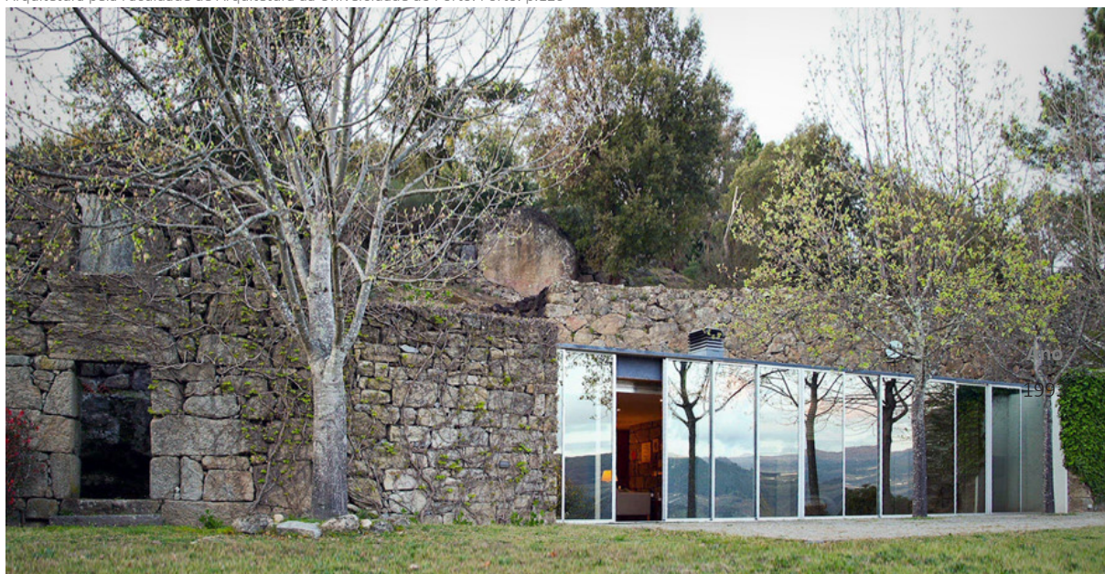
Figura 48. A relação entre a ruína e o plano envidraçado da casa
