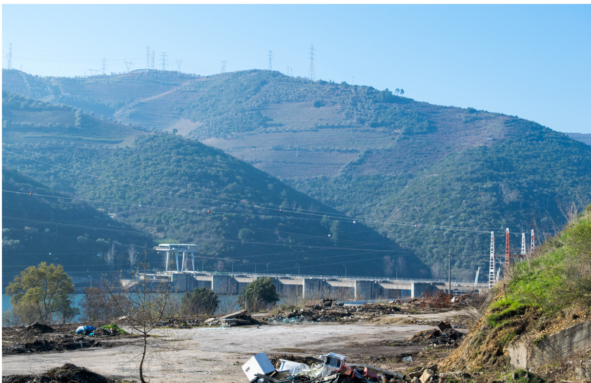
Figura 7. Vista do terreno para a Barragem do Bagaúste Imagem do autor
