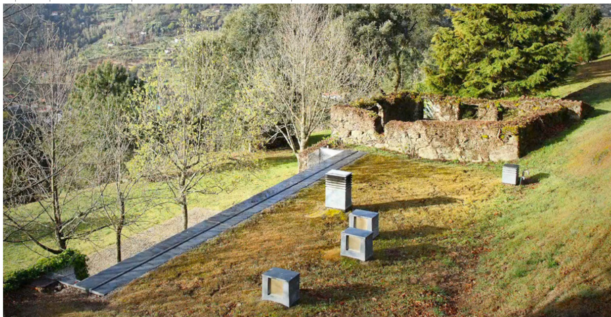
Figura 49. Vista da cobertura ajardinada e das paredes da ruína
