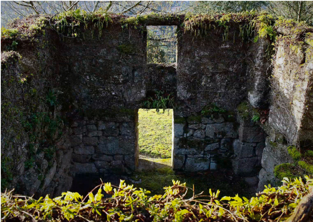
Figura 50. Vista para a ruína
