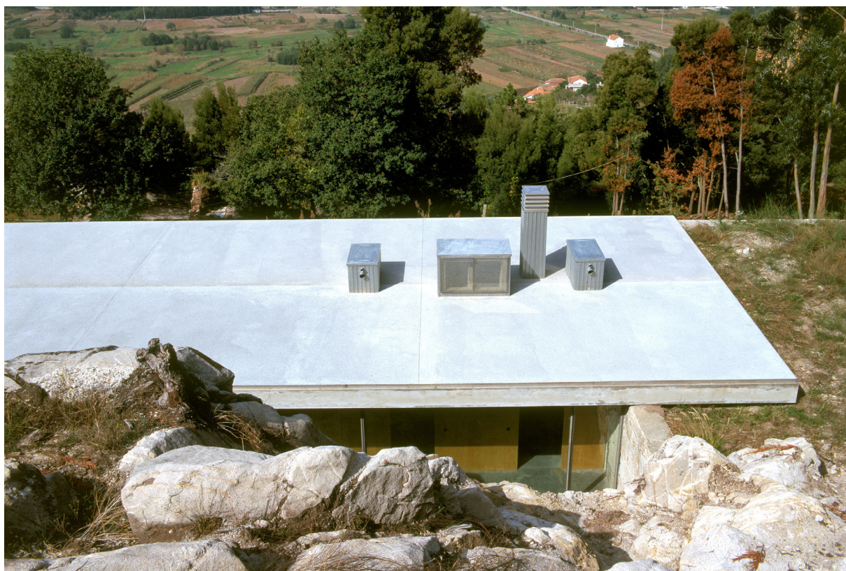
Figura 58. Vista aérea Imagem do obtida em: https://www.atlasofplaces.com/architecture/casa-en-moledo/
