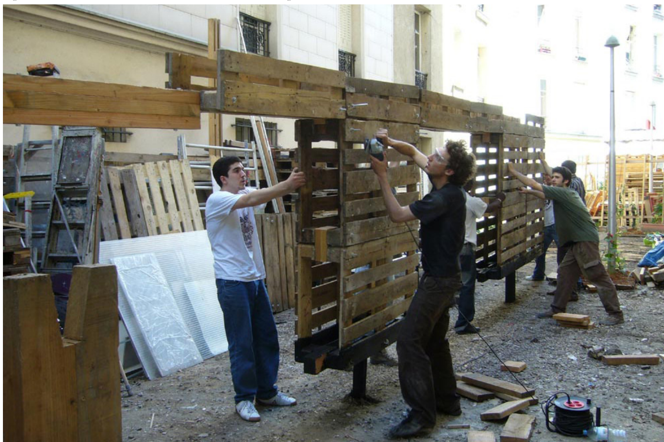
Fig.3 - Comunidade a montar uma estrutura no Passage 56
