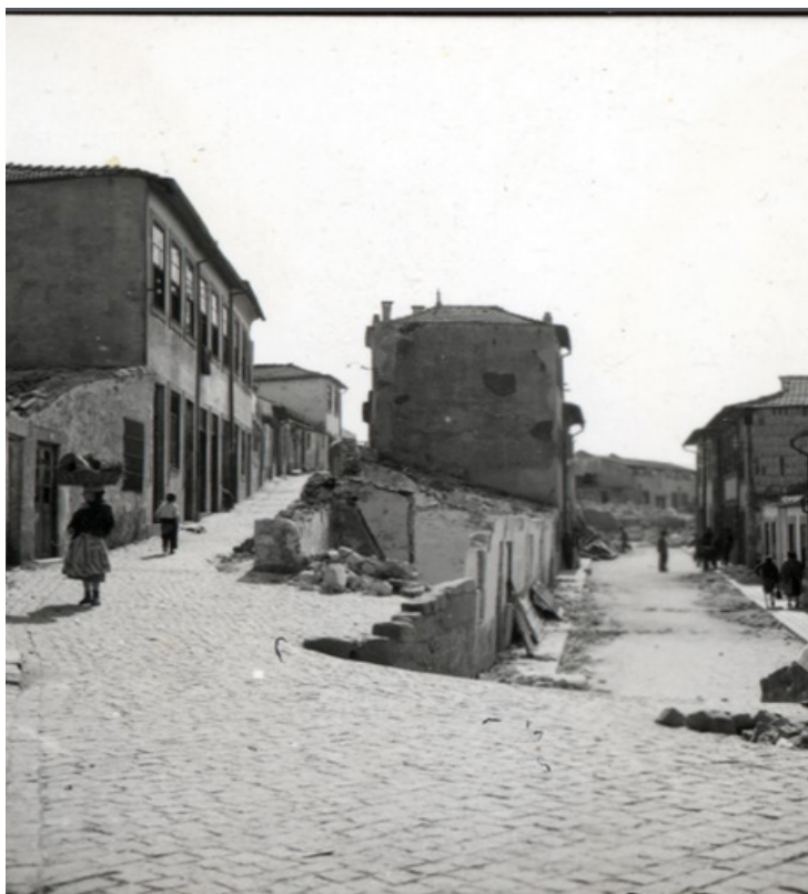
Fig. 2 - Demolição das 'ilhas' na travessa das Eirinhas, Bonfim, 1960
