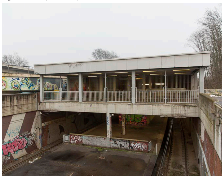
Fig.9 e 10 - A estação de metro Eichbaum, antes da intervenção
