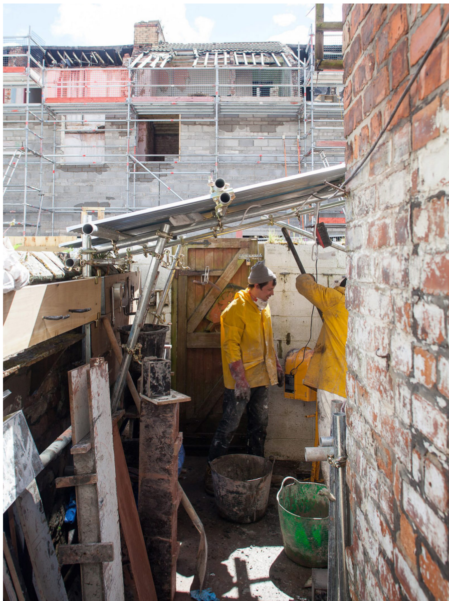
Fig.9 - Oficina montada no logradouro de uma das casas
