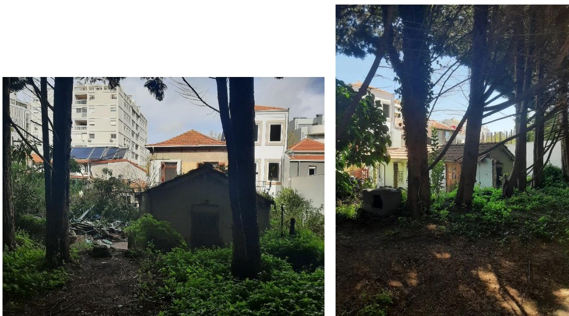
Figura 32 - Problema 8: baixa qualidade visual/falta de vedação
