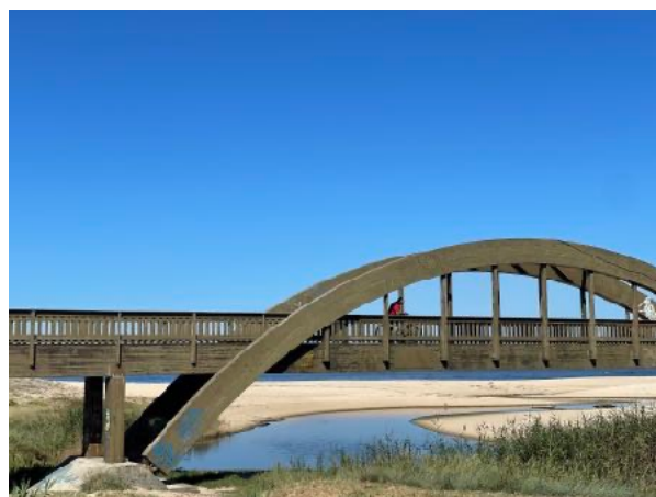
Fig. 30 Ponte pedonal do Rio Onda | Autor julho 2022
