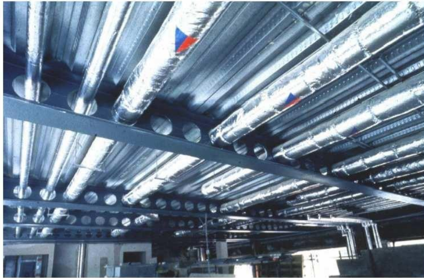
Figura 1.1 - Vigas com aberturas regulares [39]
