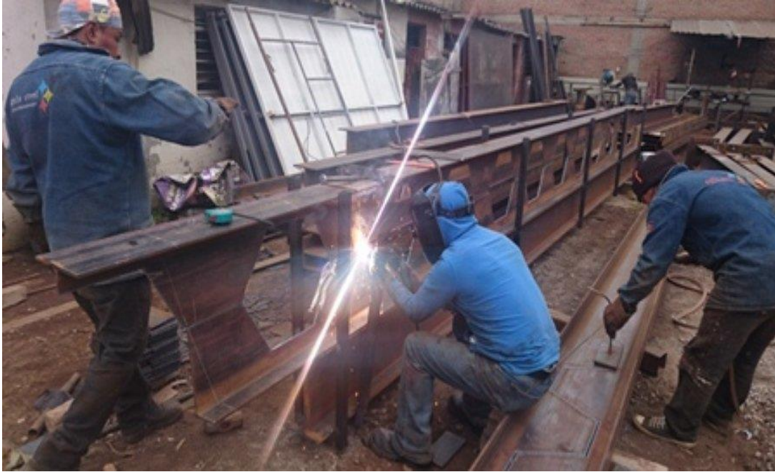
Figura 2.10 - Fabricação das vigas casteladas com aberturas hexagonais [82]
