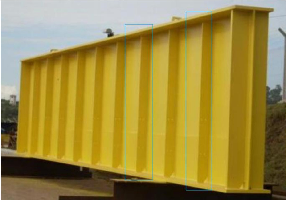
Figura 2.1 - Enrijecedores na alma de uma viga perfil I [80]
