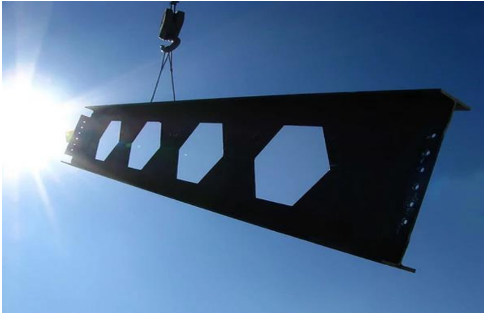
Figura 1.2 - Vigas casteladas com aberturas hexagonais [79]
