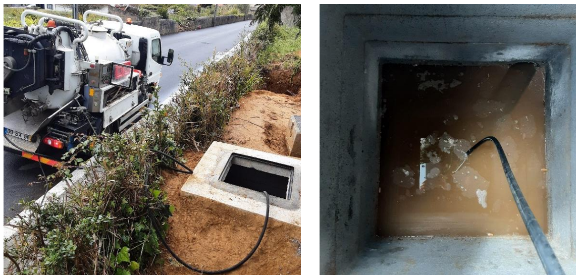
Figura 4.2. Desentupimento de um ramal de saneamento.
