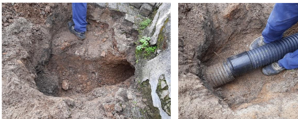
Figura 4.1. Prolongamento do ramal de águas residuais.
