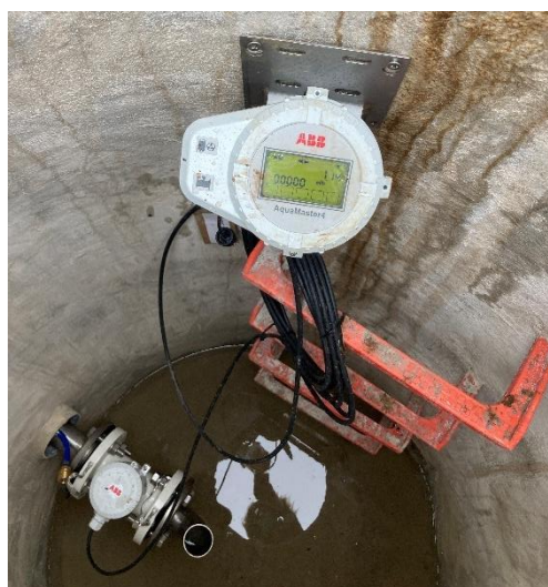
Figura 4.13. Exemplo de um caudalímetro.
