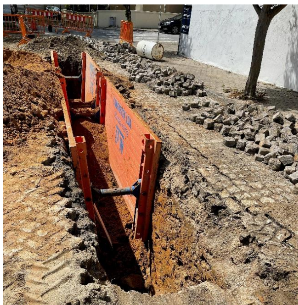
Figura 4.3. Reabilitação de um coletor de águas residuais.
