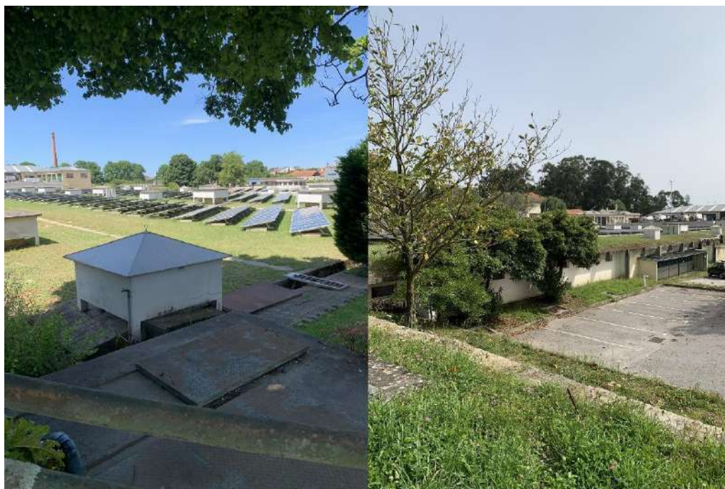
Figura 2. 12 – Reservatório de Nova Sintra, no Porto (células semienterradas).
