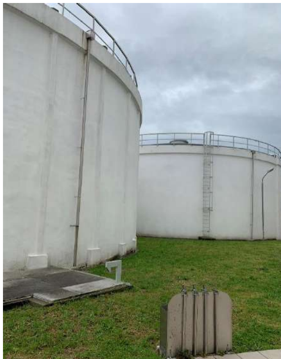
Figura 2. 10 – Reservatório dos Congregados, no Porto (células apoiadas)
