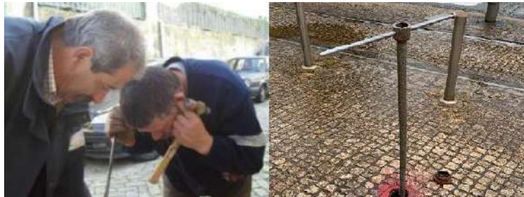
Figura 3. 12 – Funcionamento de uma haste de som tradicional na AEdP.
