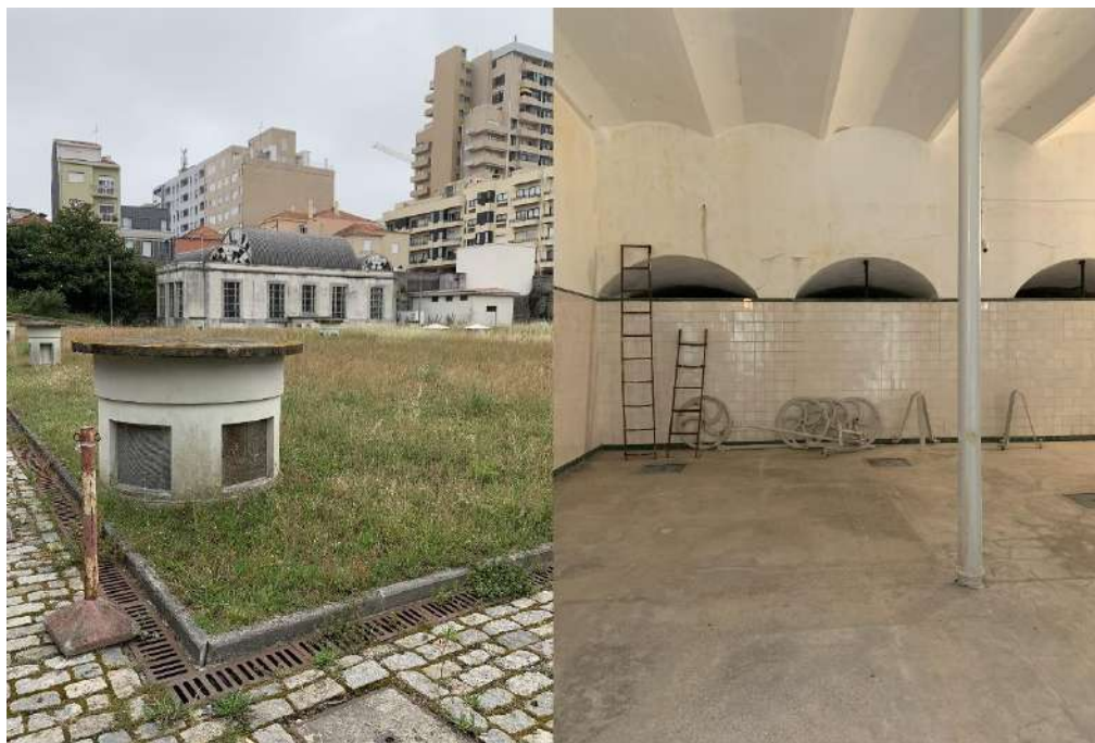
Figura 2. 11 – Reservatório de Santo Isidro, no Porto (células enterradas).
