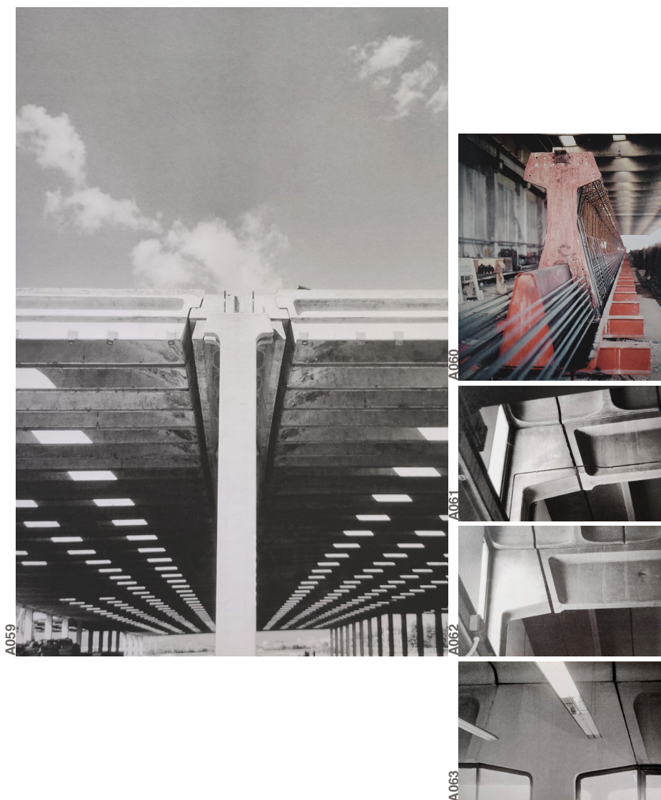
A059 Pormenor do sistema de pre-fabricação U70 Isocell, na fábrica Lema, de Mangiarotti
