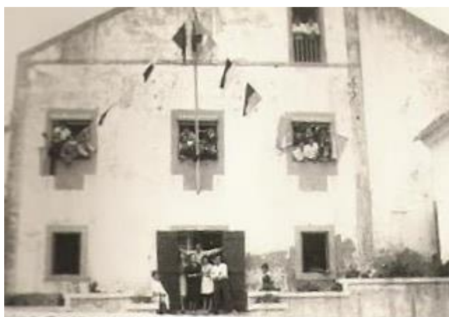
Figura 4 - Sede da SIT antes da requalificação
