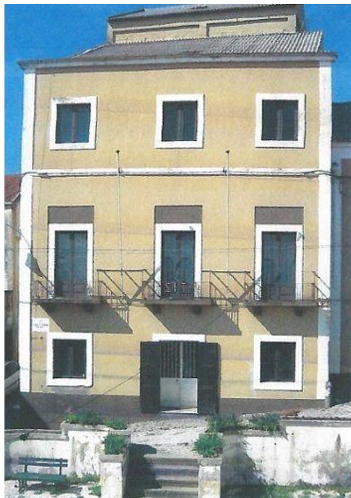
Figura 3 - Sede da SIT após requalificação
