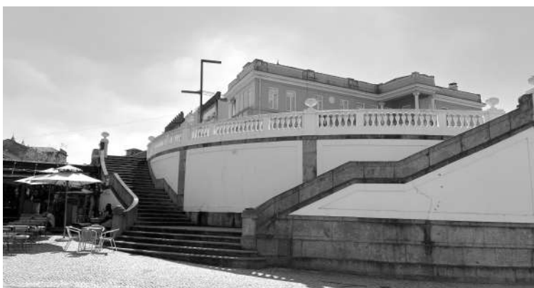
14. Escadaria norte atual da autoria do arquiteto José Marques da Silva
