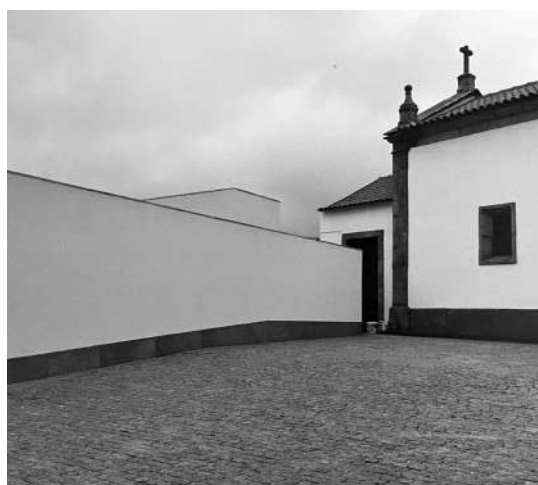
54. A capela e o início do percurso rampeado
