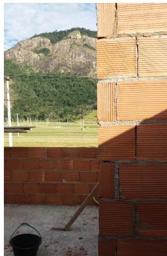
Figura 11 - Parede em alvenaria com blocos cerâmicos. Arquivo pessoal.
