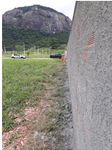
Figura 15 - Chapisco em muro. Arquivo pessoal.
