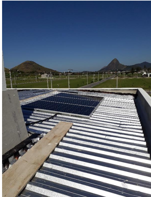
Figura 13 - Telhado com telha metálica. Arquivo pessoal.
