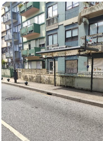
Foto 2: Exemplo da paragem de tipologia parcial
