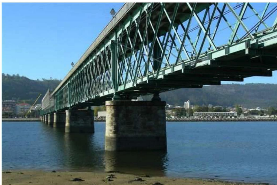
Figura 5 - Ponte Eiffel vista da margem esquerda [11]
