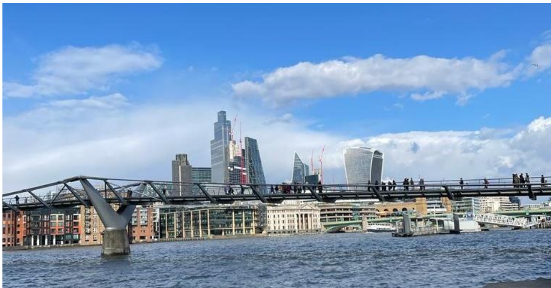
Figura 12 - Millennial Bridge vista em alçado
