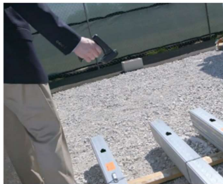
Fig. 2.10 – Leitura de etiqueta RFID em material de construção (Sawhney et al., 2020)
