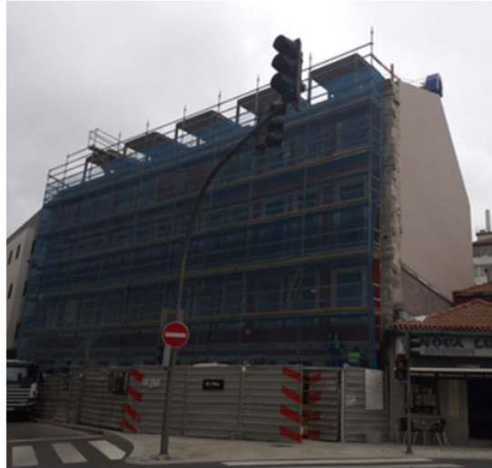
Fig. 4.1 – Fotografia da fachada do edifício principal durante a ocorrência da obra
