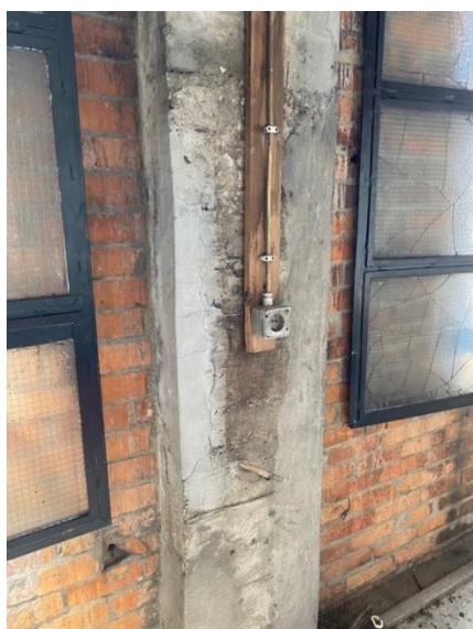
Figura 3.5 – Fissuração
