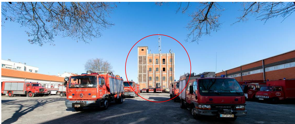
Figura 3.1 – Edifício “Casa Escola BSP”
