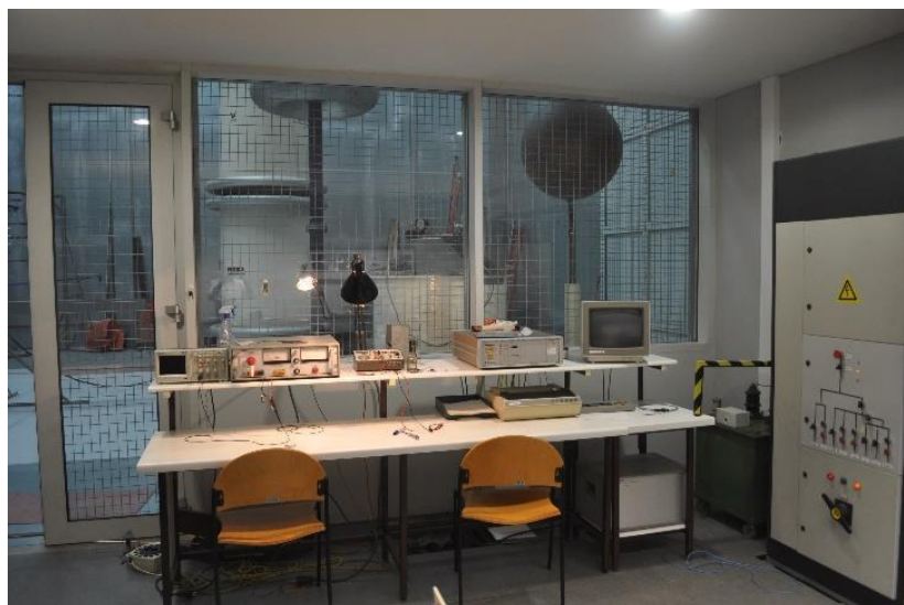
Figura 2.2 - Sala de Controlo
