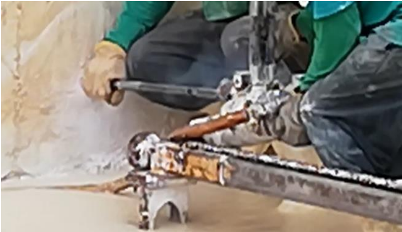
Figura 47. Fixação da haste com prensa manual no furo horizontal.
