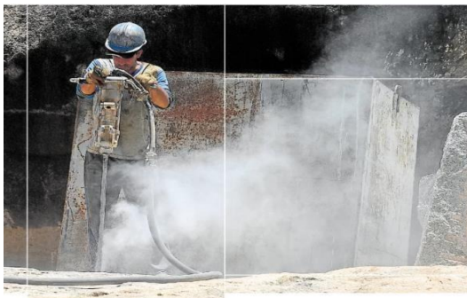
Figura 53. Perfuração a seco no granito com martelete manual.
