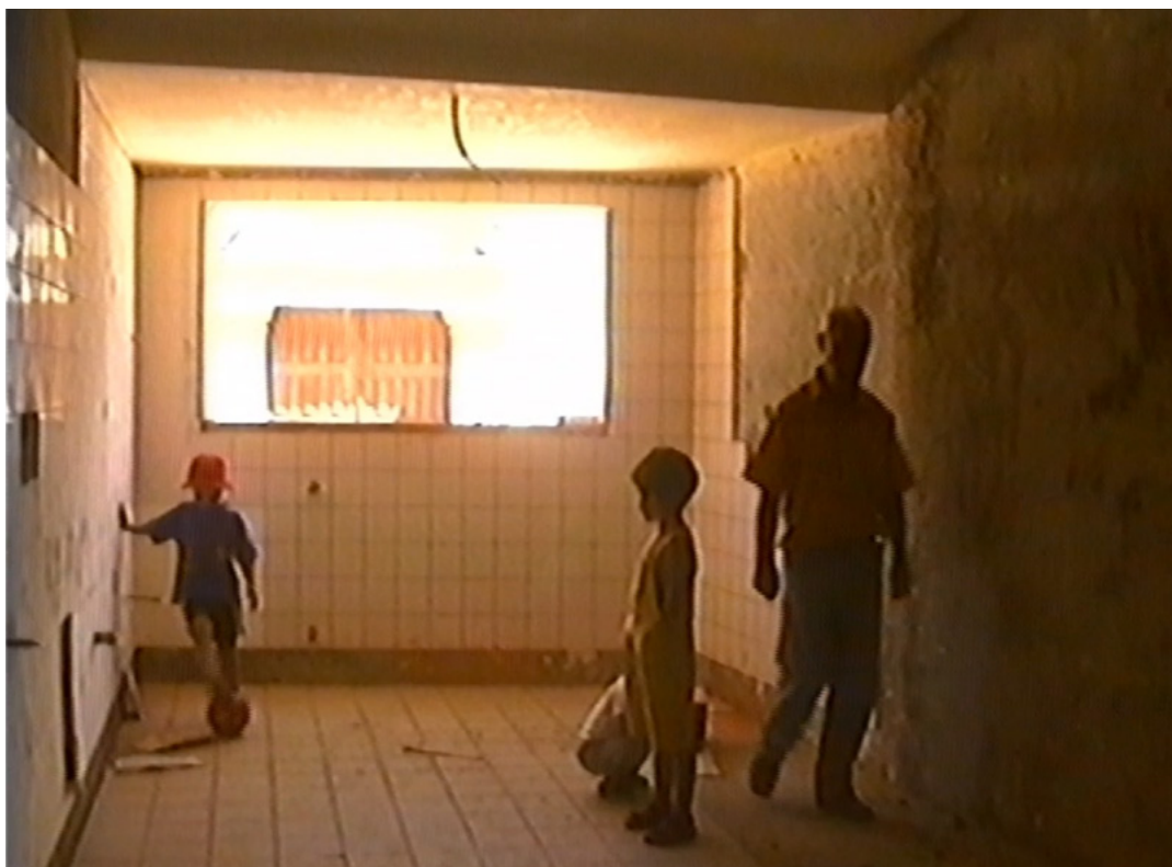
Brincadeiras na cozinha nova em obras. Agosto 2000
