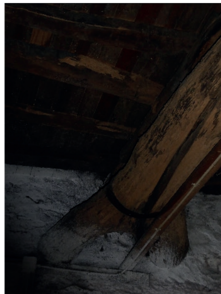
Fig.37. Viga em tronco de madeira apoiada na parede de alvenaria. Garagem.
