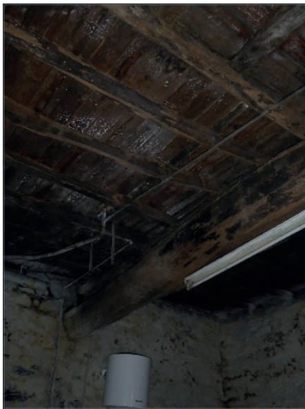
Fig.38. Garagem, área do quarto da Casa norte. Estrutura do sobrado: Viga em tronco de árvore, estrutura do soalho e soalho.
