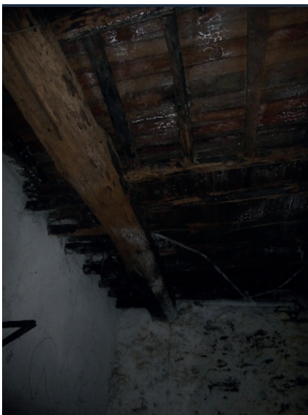
Fig.39. Garagem, área da casa de banho da Casa norte. Estrutura do sobrado: Viga em tronco de árvore, estrutura do soalho e soalho.
