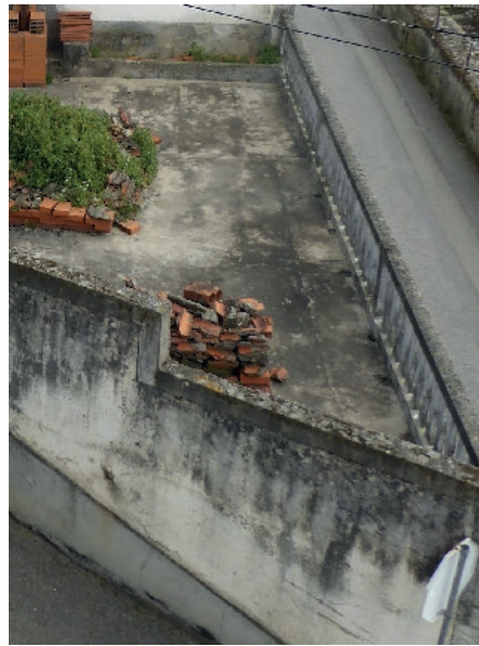
Fig.36. Cobertura do lagar e terraço exterior.
