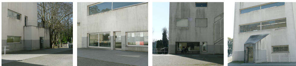
Fig. 32 - Fachada Norte dos edifícios H, G, F e E, respectivamente, onde se localizam as entradas autónomas a cada um deles, a partir do nível do pátio central.
