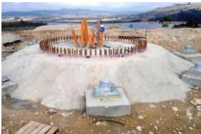
Figura 2.13 – Sapata de estacas [21]
