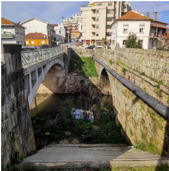
Figura 22 - Ponte da Pedra, São Mamede de Infesta (Fonte: https://bussola-pt.com/211244/ponte-da-pedra )
