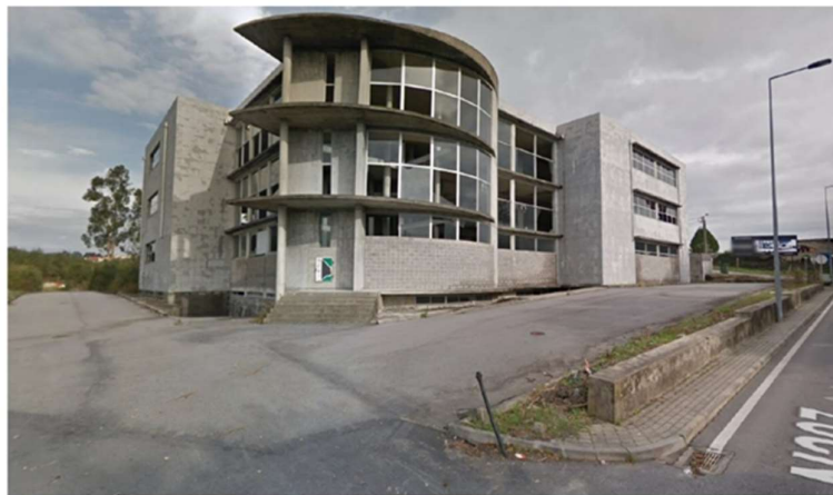
Fig. 3.4. Edifício antes da conversão.
