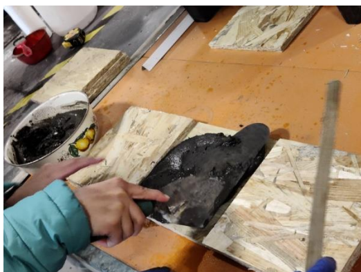
Figura 3.8. – Aplicação da argamassa de reboco nas placas de OSB
