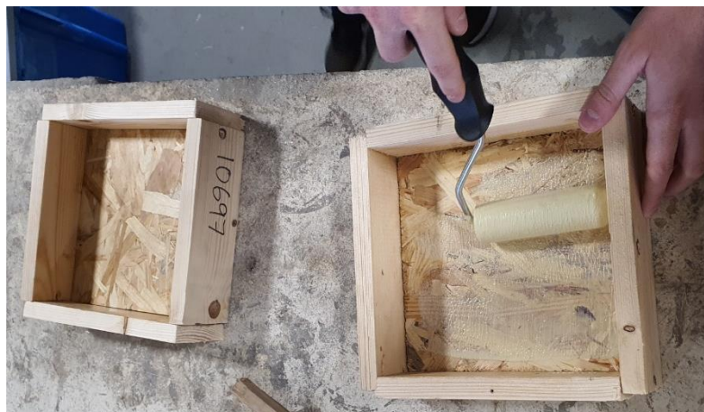
Figura 20 - Aplicação da solução de primário na base dos moldes a qual é constituída por uma placa de OSB
