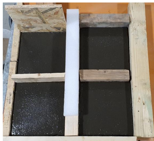
Figura 21 - Colocação e espalhamento da argamassa na placa de OSB (à esquerda); Aspeto final dos moldes com argamassa para reboco exterior do SIP para iniciar processo de cura (à direita)
