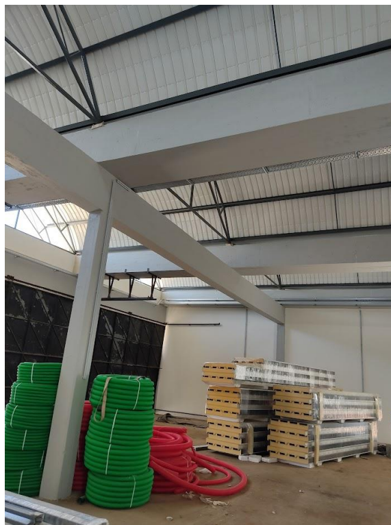
Figura 7 - Resultado final após tratamento da estrutura e alvenaria
