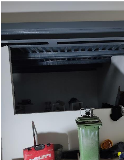
Figura 8 - Estrutura em mezanino
