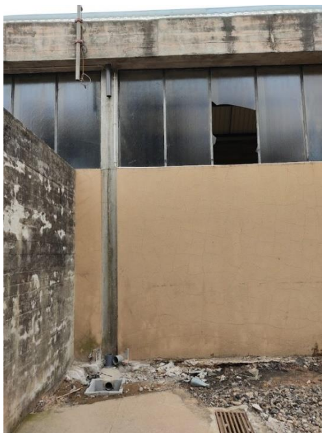
Figura 9 - Vãos envidraçados do edifício principal
