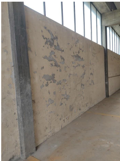
Figura 6 - Alvenaria e estrutura do edifício principal, antes da intervenção
