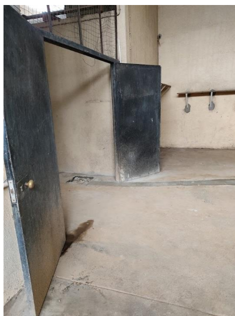
Figura 10 - Vãos metálicos das portas e portões do edifício principal
