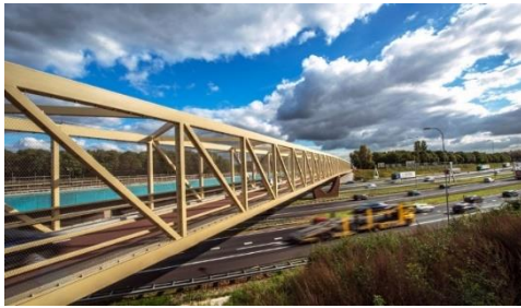
a) Utrecht A27 Lunetten, híbrida de aço e GFRP [28]
