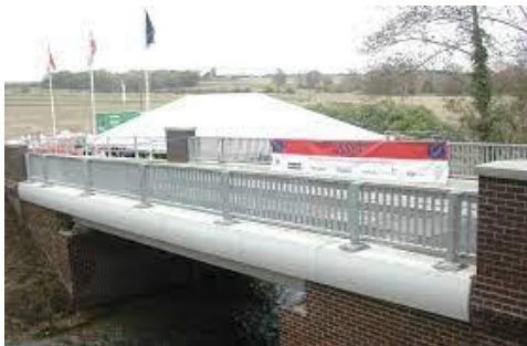
c) West Mill Bridge (Oxfordshire 2002), híbrida de aço e GFRP [17]
