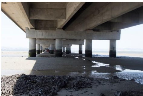
c) Viaduto Ponte Vasco da Gama, Lisboa, EBR [31]
