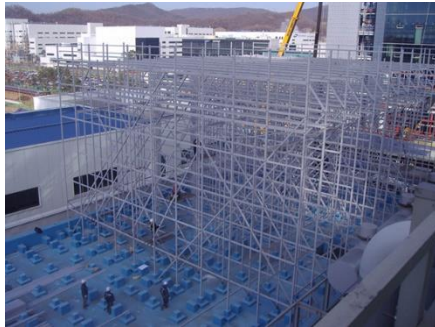
a) Torre de arrefecimento, [33]
