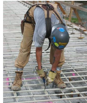
b) Operação de fixação dos varões de GFRP
