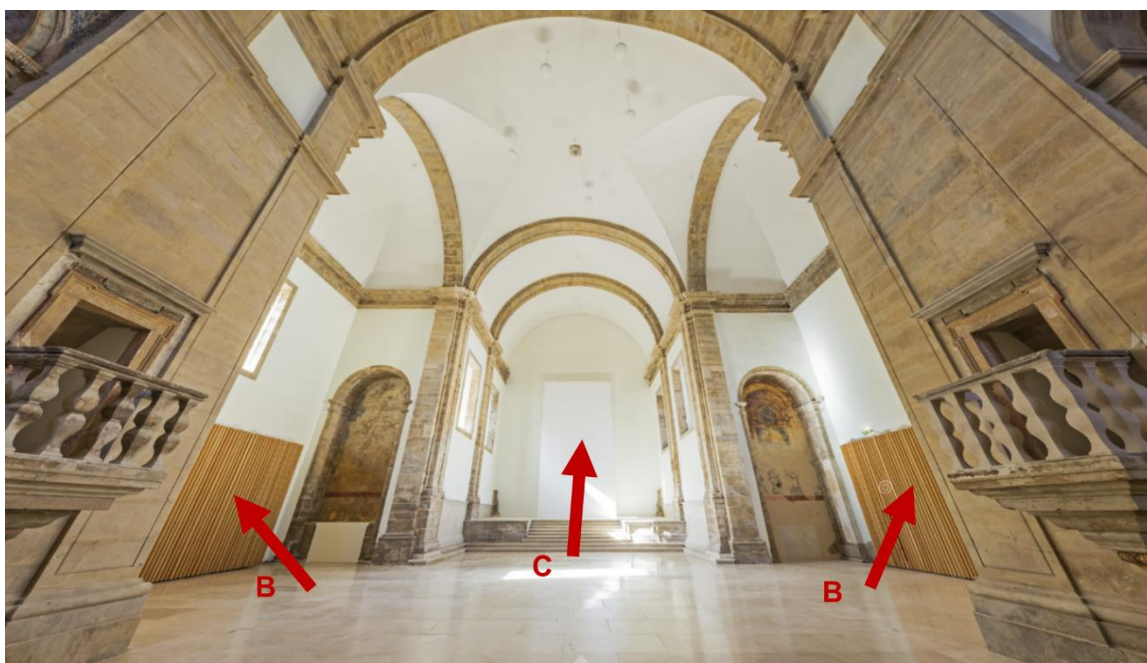
Fig. 4.15 - Interior da Igreja reabilitada de São Francisco, Coimbra. Painéis difusores sonoros de madeira colocados em cada uma das paredes laterais do transepto (B) e painel refletor sonoro em madeira no coro (C) [46]
