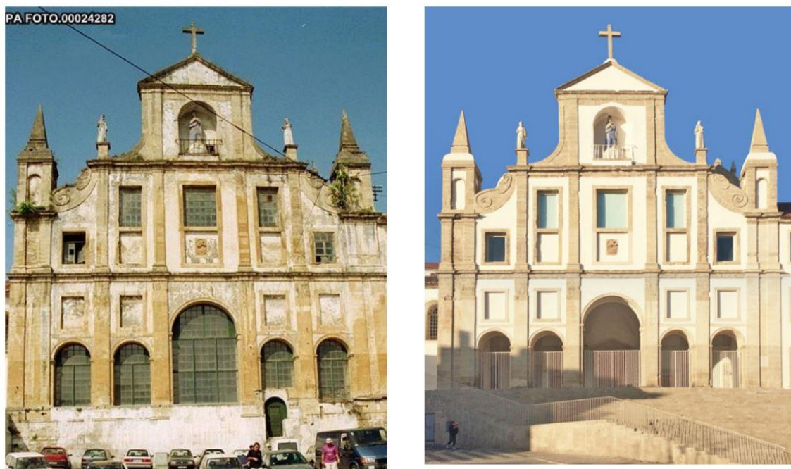
Fig. 4.9 - Comparação da fachada da igreja de São Francisco, antes (esq.) e depois (dir.) da reabilitação [35]
