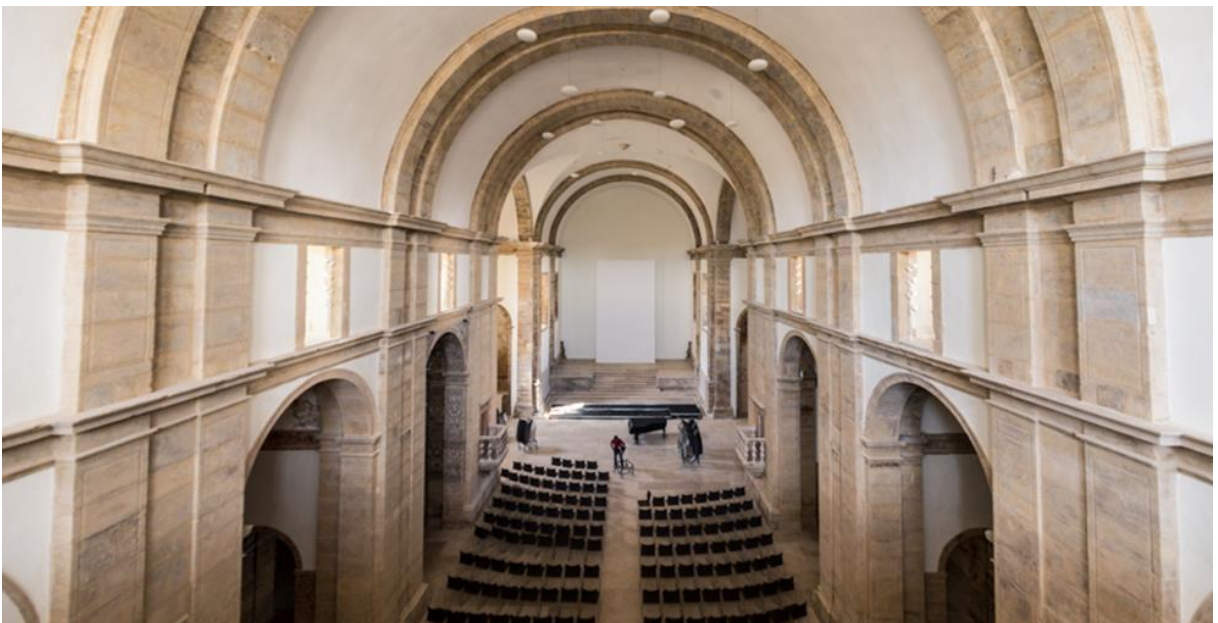
Fig. 4.6 - Interior da igreja reabilitada de São Francisco, Coimbra, agora Sala D. Afonso Henriques do Centro de Cultural e de Congressos de Coimbra [45]
