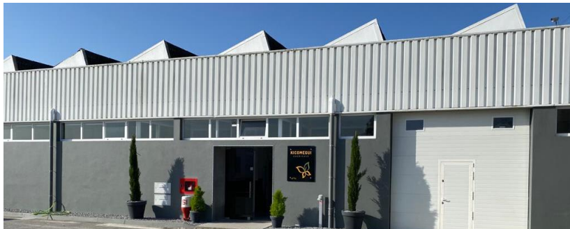
Figura 1- Fotografia das instalações da empresa Kicomegui, Lda [5].
