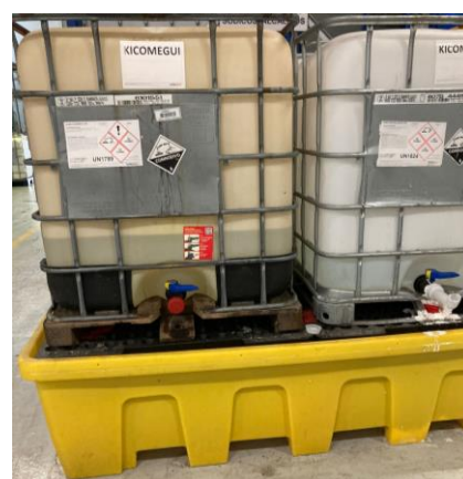
Figura H-3- Bacia de retenção.
