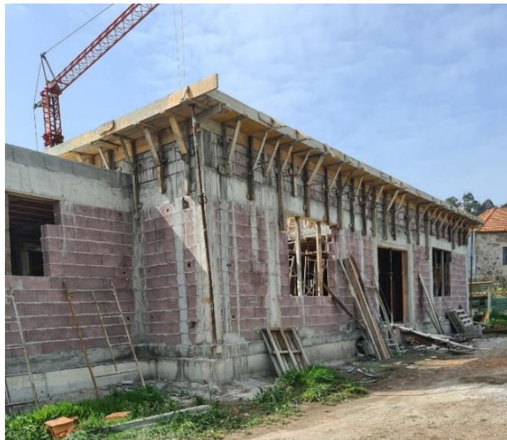
Figura 3.4- Fachada Caso de Estudo A
