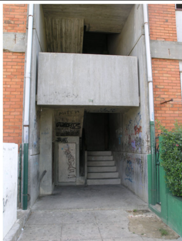
CAIXA DE ESCADA
