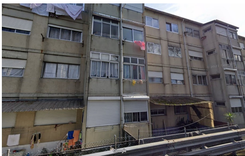
Figura 7 - Bairro de Bessa Leite (Foto retirada do Google Street View, Captura de Imagem em Março/2022)
