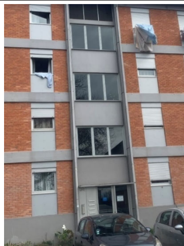
CAIXA DE ESCADA
