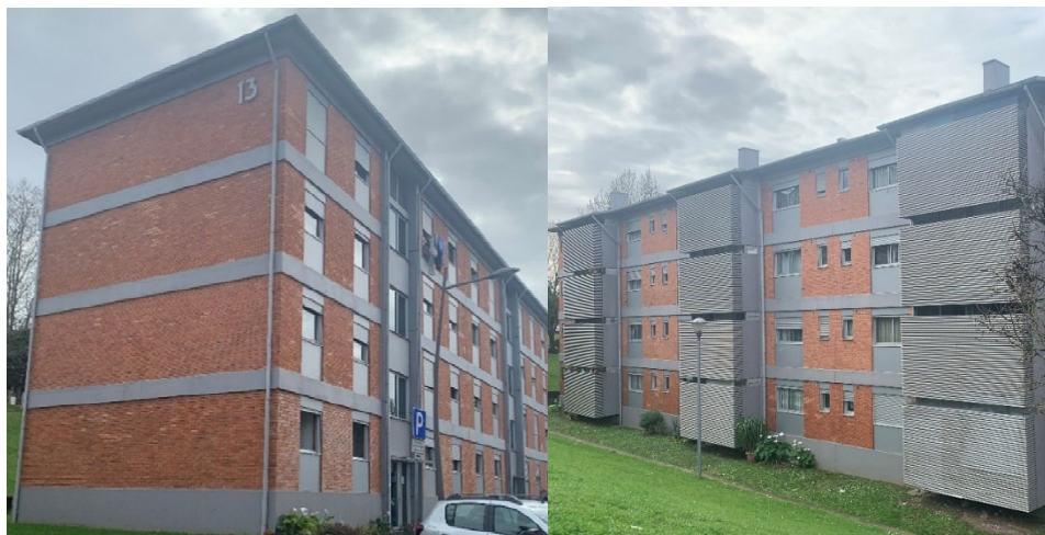
Figura 46 - Edifício na fase 2: Pós-reabilitação
