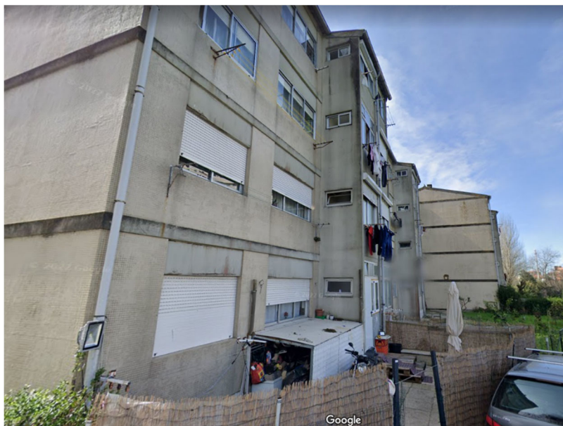
Figura 6 - Bairro de Bessa Leite (Foto retirada do Google Street View, Captura de Imagem em Março/2022)
