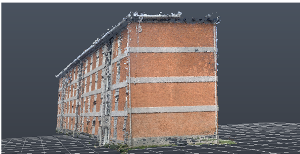
Figura 31 - Nuvem de pontos do Edifício em estudo após a limpeza
