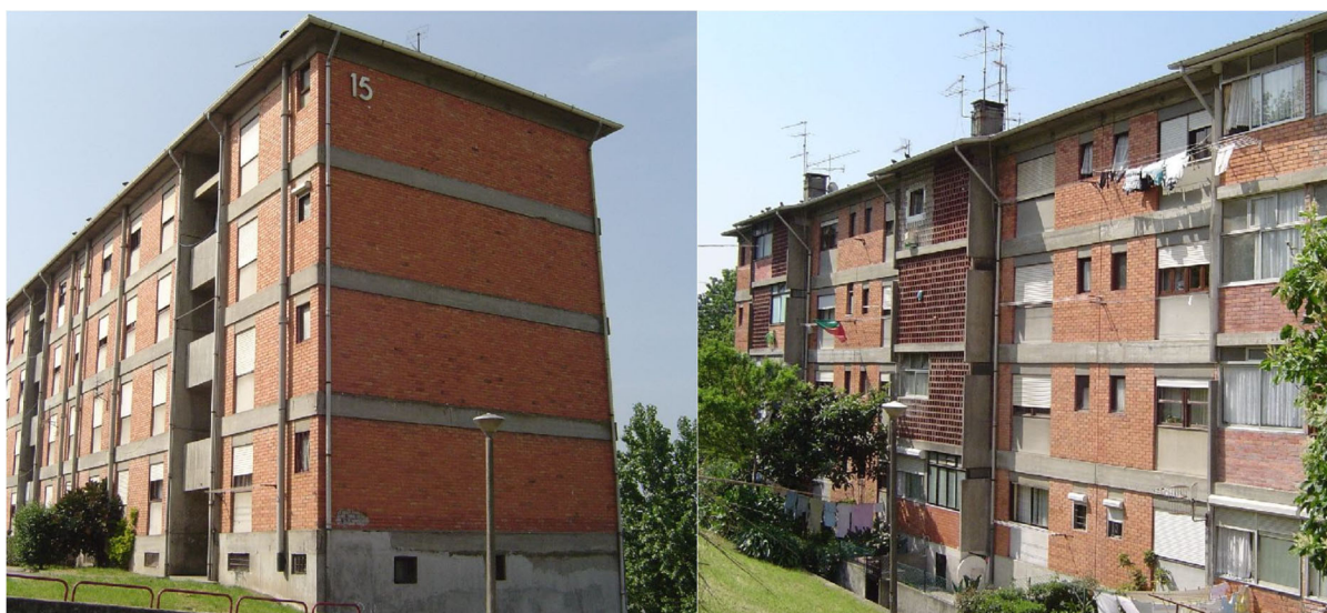
Figura 45 - Edifício na fase 1: Pré-reabilitação
