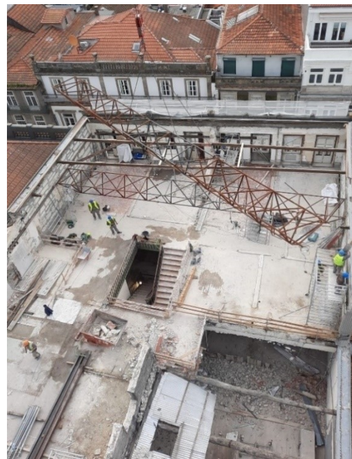
Fig.19 – Colocação de contenções metálicas.
