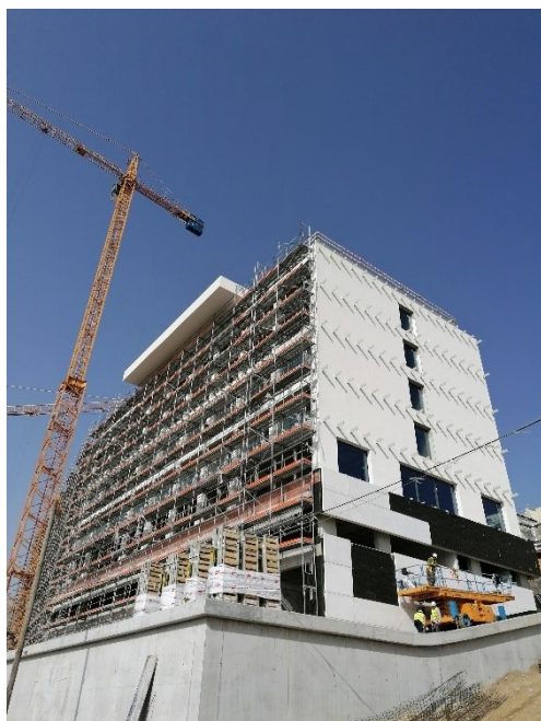
Fig.13 e 14 – Fase de aplicação de isolamentos na fachada.
