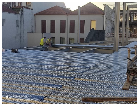
Fig.20 – Colocação de chapa colaborante para as lajes mistas.
