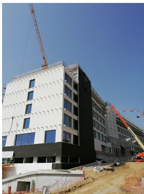
Fig.13 e 14 – Fase de aplicação de isolamentos na fachada.
