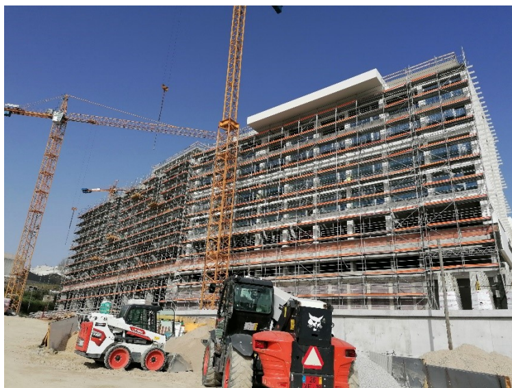
Fig.12 – Frente de obra.
