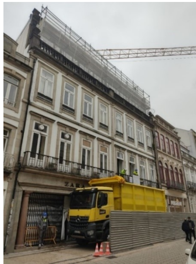
Fig.17 – Fachada existente da obra caso de estudo 2.
