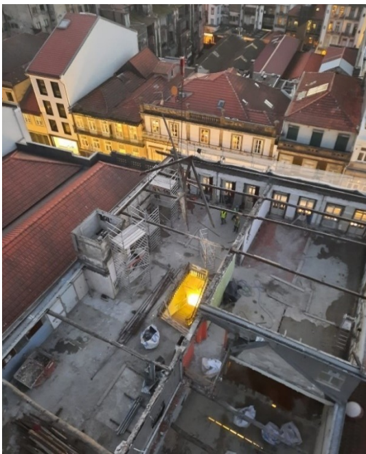
Fig.18 – Demolições no edifício existente.
