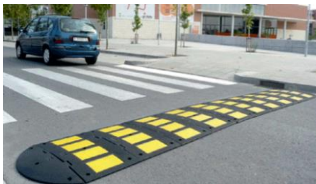
Fig.30- Lomba redutora de velocidade
