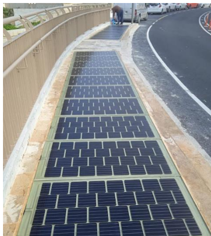
Fig.34- Painéis fotovoltaicos da Solar Innova
