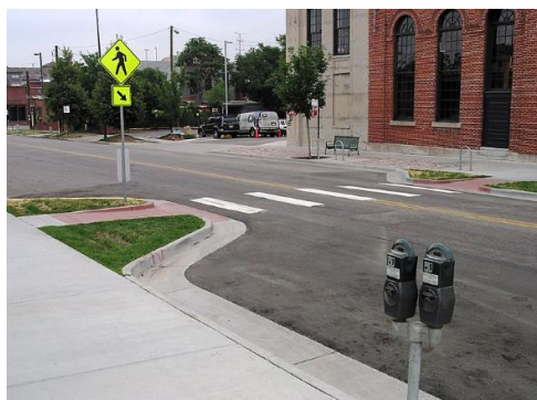
Fig.27- Estrangulamento com redução da distância de travessia para peões
