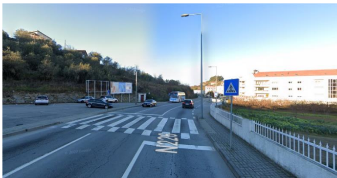
Fig.31- Passagem pedonal elevada (Google Maps)
