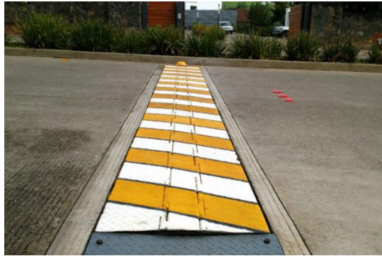
Fig.39- Tope Inteligente quando os veículos circulam a velocidades legais
