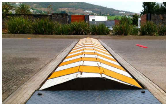
Fig.38- Tope Inteligente quando os veículos excedem os limites de velocidade
