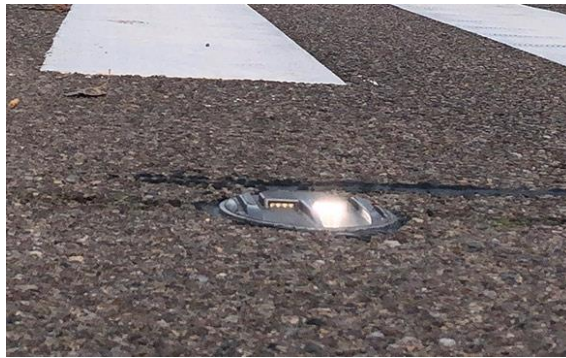
Fig.44- Iluminação embutida com LED do sistema Paso de Peatones Inteligente
