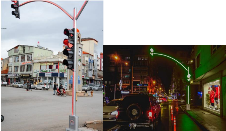
Fig.46- Postes de sinalização de trânsito Ekaldes
