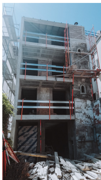
112. Recuperação da fachada tardoz
