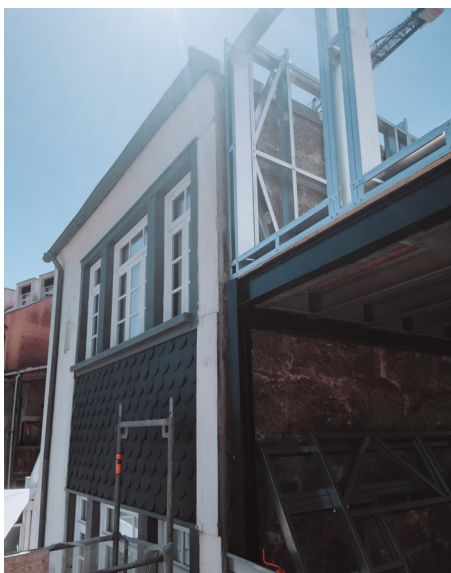
118. Colmatção com fachada tardoz do prédio vizinho
