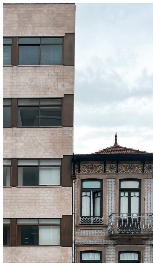
65. Rua da Constituição, Porto
