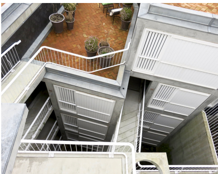
99. Galeria de acessos - vista superior
