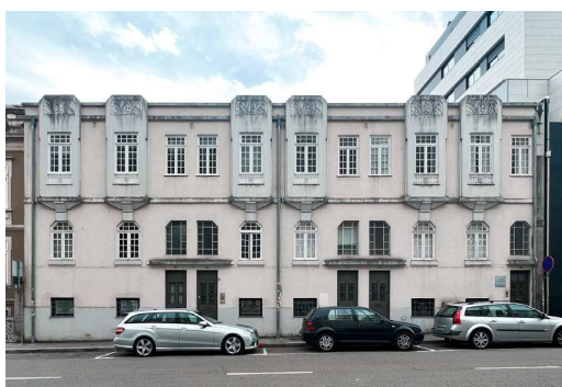
45. Edifício de habitação bifamiliar Inova Casas, João Queirós (1930)
