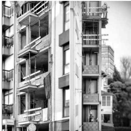
144. Fachada principal e tardoz em construção
