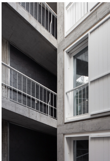
97. Galeria de acessos
