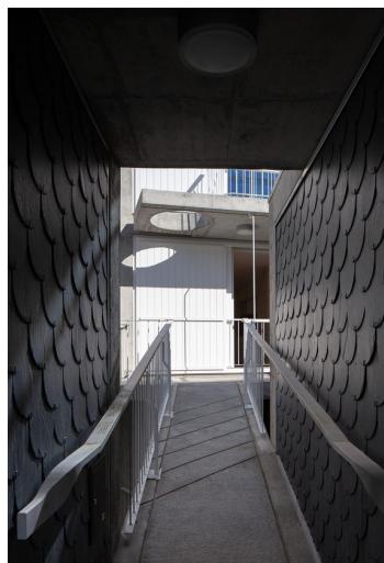
98. Galeria de acessos
