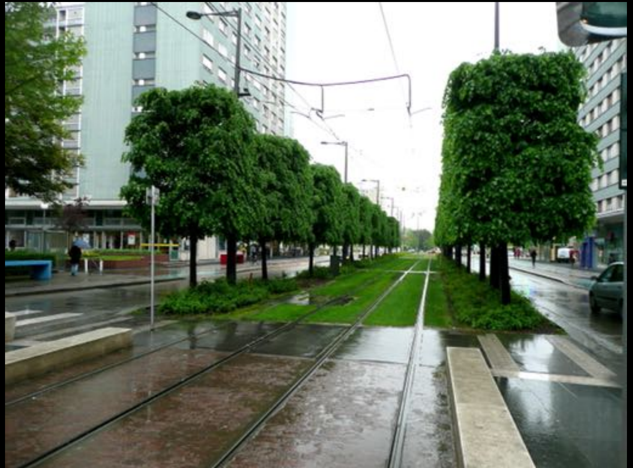
Estrasburgo. Avenue Colmar. Após a intervenção do Metro
