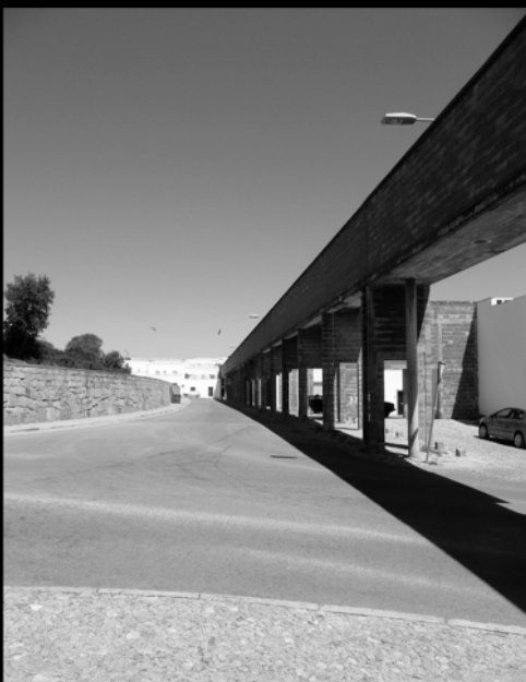
Bairro da Malagueira
