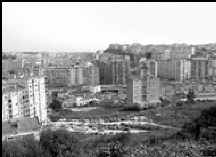
Perspectiva desde a Rua de Cabo Verde Antes da intervenção
