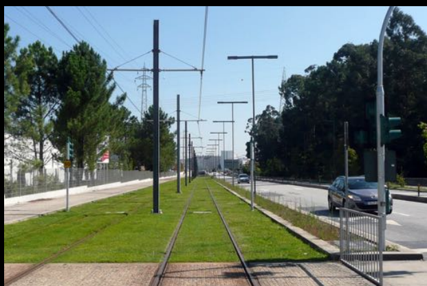
Avenida F. Sá Carneiro (Zona Industrial)
