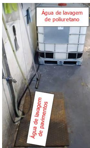
Fig. 77 – Caixa de água para água de lavagem de pavimentos e IBC para água de lavagem de poliuretano.
