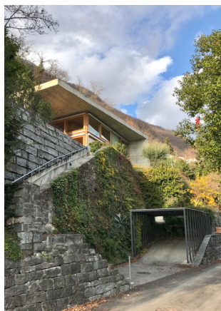
Vista da entrada, sequência de escadas e espaço para o carro
