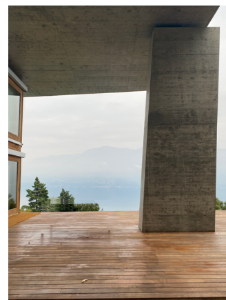
Estrutura em betão, pilar inclinado, "Arquitectura Neolítica"
