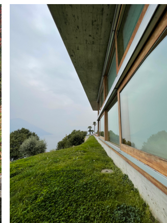
Vista exterior, cobertura e caixilharia
