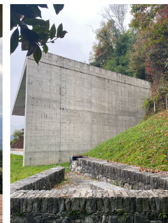
Alçado Noroeste, parede cega e espaço de estar com grelhador
