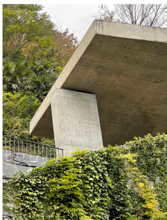
Estrutura em betão, onde o pilar avança sobre a cobertura
