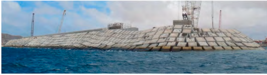
Fig. 1. Sal-Rei breakwater. Courtesy of Van Gent and van der Werf (2017).
