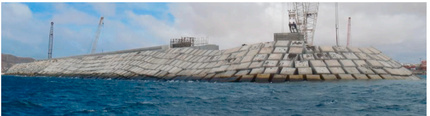
Fig. 1. Sal-Rei breakwater. Courtesy of Van Gent and van der Werf (2017).
