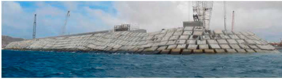
Fig. 1. Sal-Rei breakwater, Cape Verde. Courtesy of Van Gent and van der Werf (2017).
