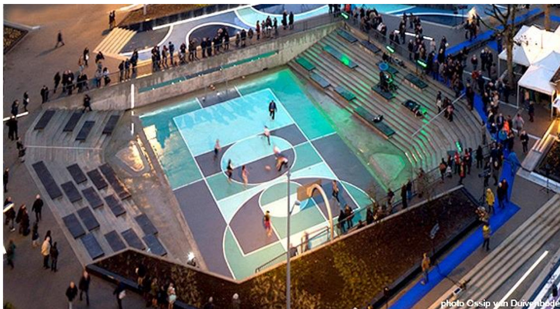
Figura 14 – Bacia superficial em Benthemplein [10]
