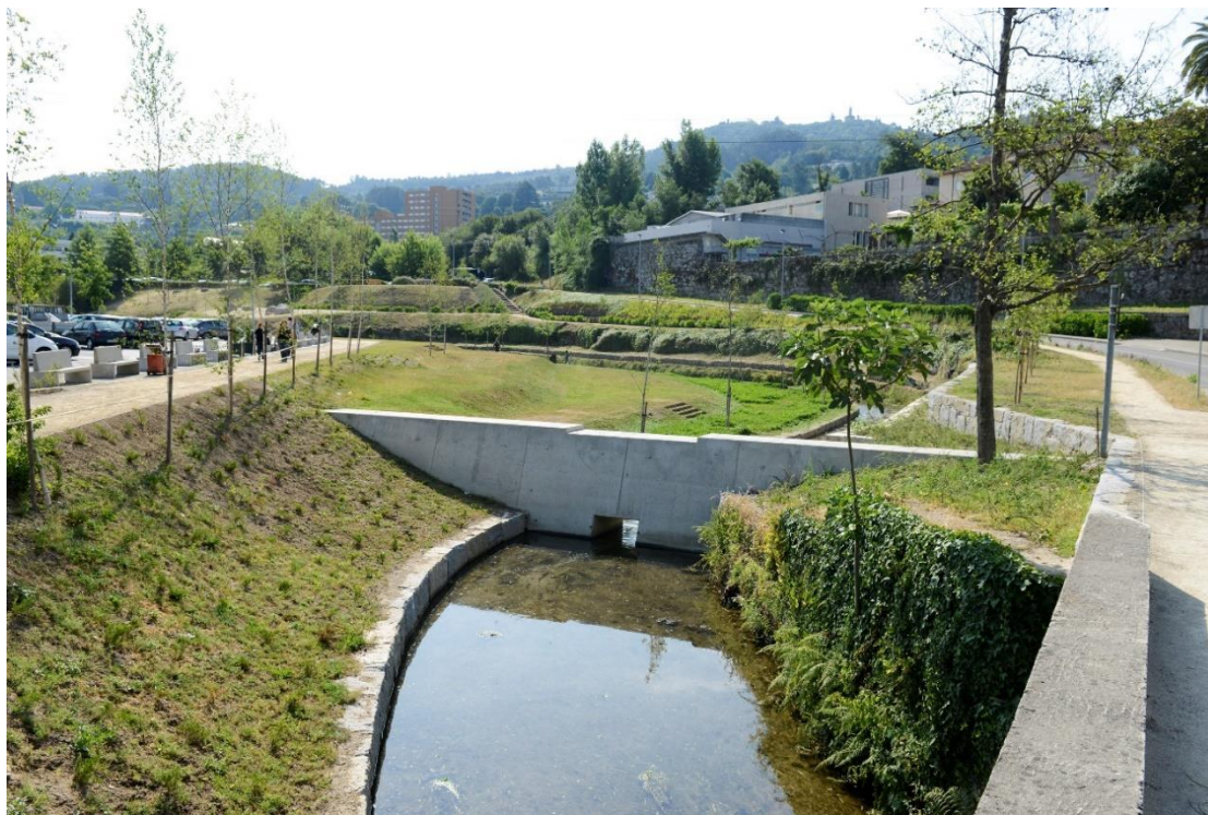
Figura 7 – Bacia de retenção na ausência de pluviosidade - Guimarães [5]
