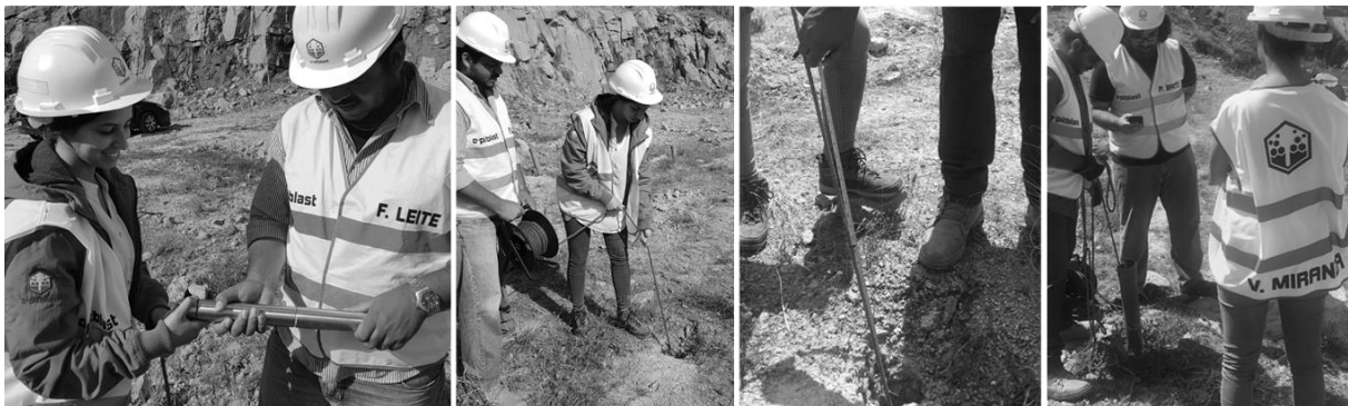
Figura 71: Uso de equipamento de medição de desvio de furos (Miranda V. et al , 2019).
