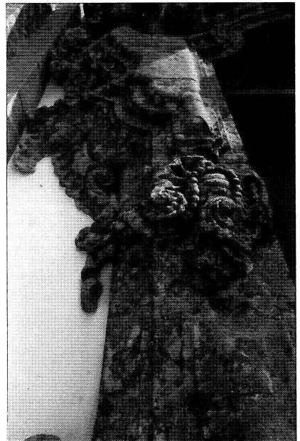
Fig. 6: Fachada da Capela da Falperra - Pormenor.
