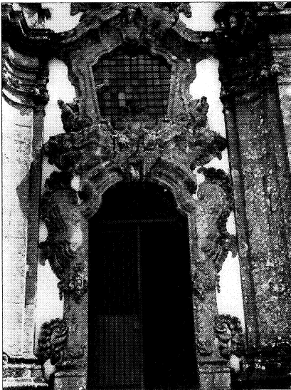
Fig. 5: Fachada da Capela da Falperra - Pormenor.
