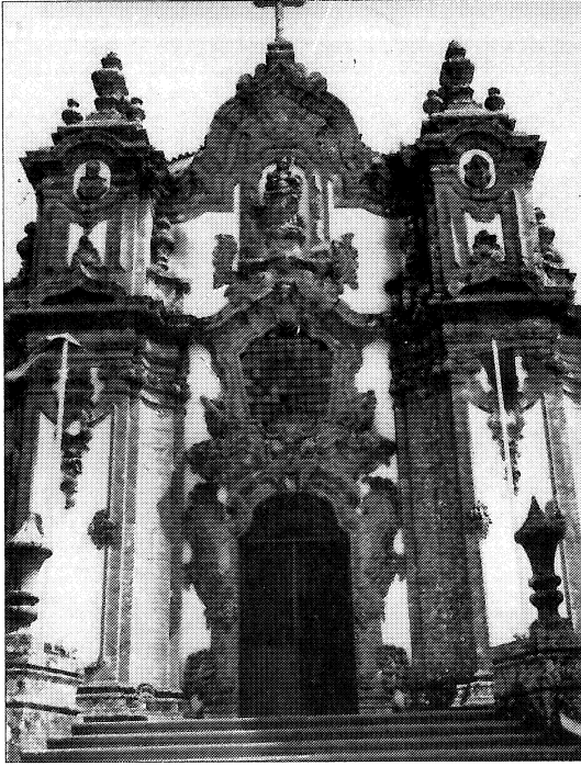
Fig. 4: Fachada da Capela da Falperra - Pormenor.
