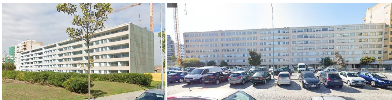
Figura 7.35 – Imagens externas edifício Nautilus Parque II. Fonte: Google Street View, 2020.
