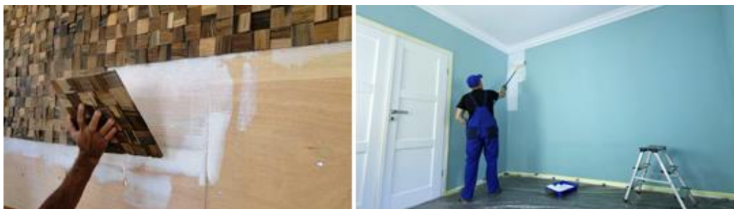
Figura 4.11 – Instalação revestimentos. Fonte: Pinheiro Tintas; Masterconstruções, 2020.
