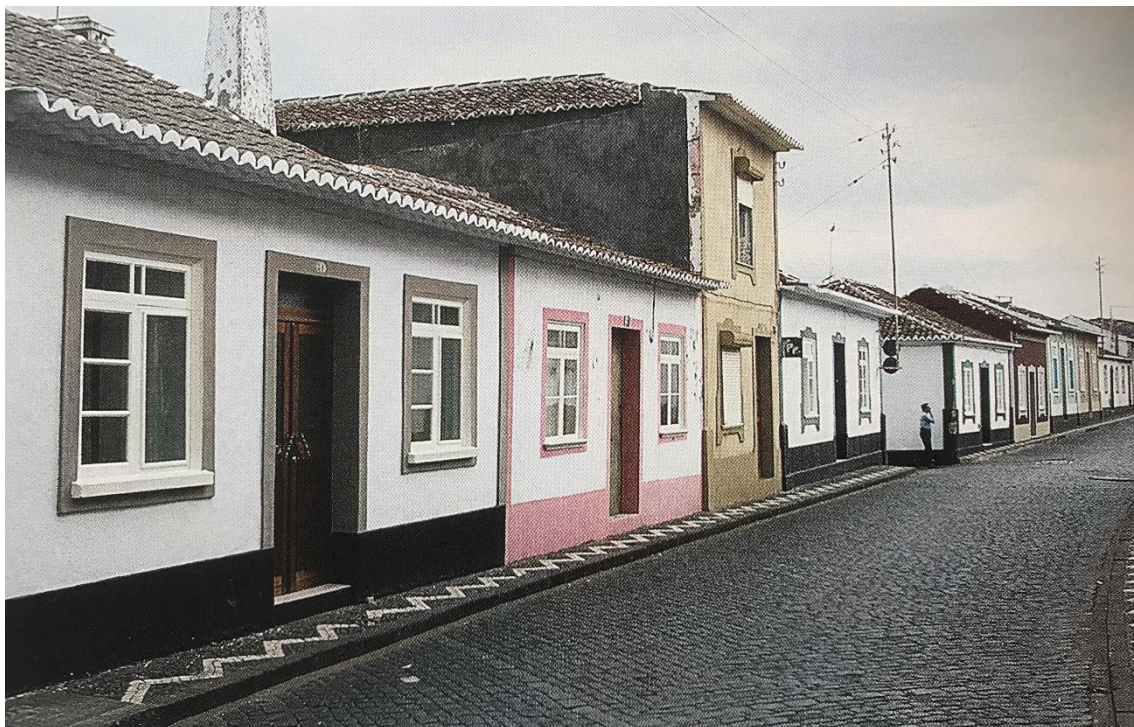
Figura 21. Casa de vila proto-urbana. Praia da Vitória, Rua Serpa Pinto, Terceira
