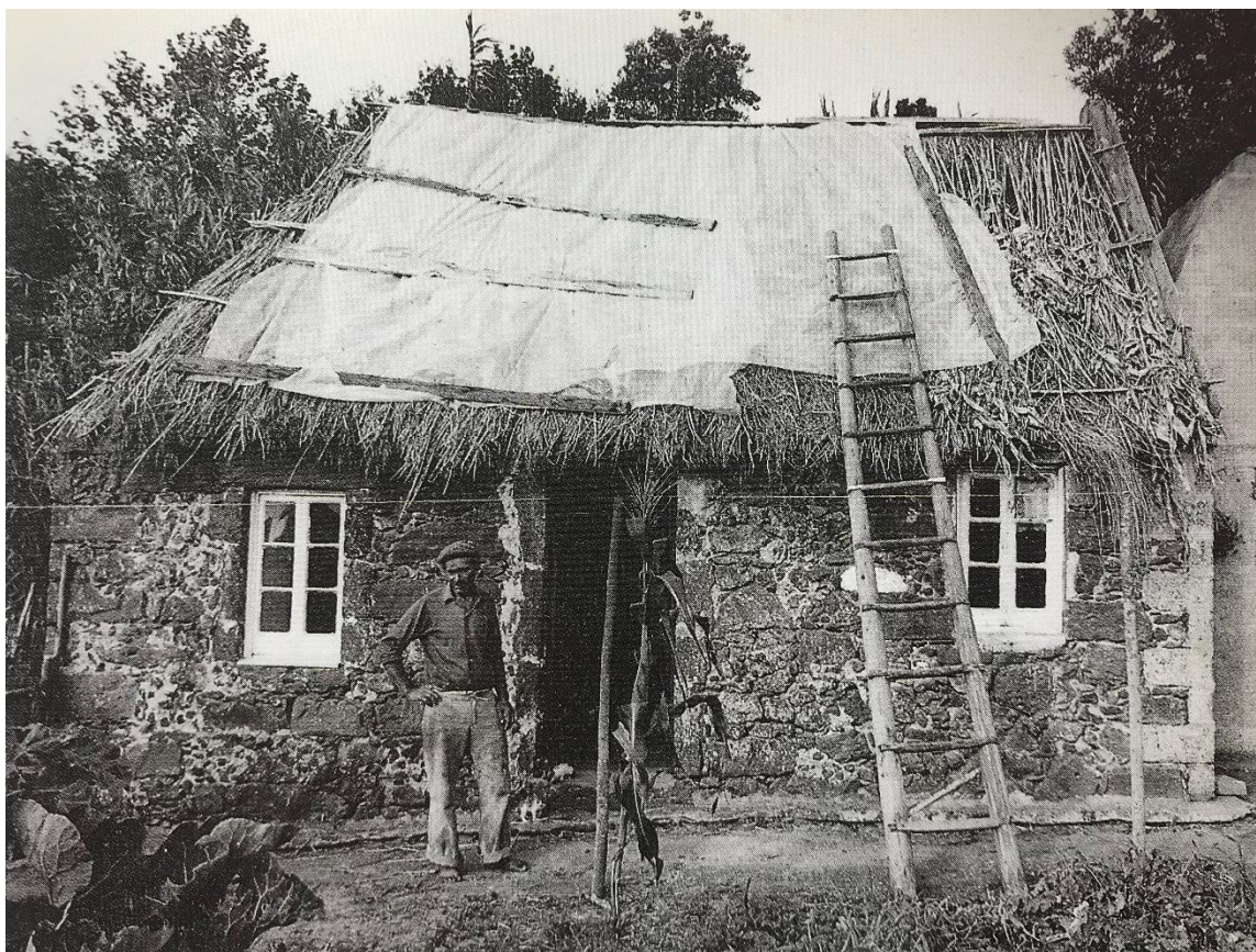
Figura 23. Casa abarracada, com cobertura de palha. Candelária, São Miguel Ocidental (levantamento arquitetônico Anexo 6)
