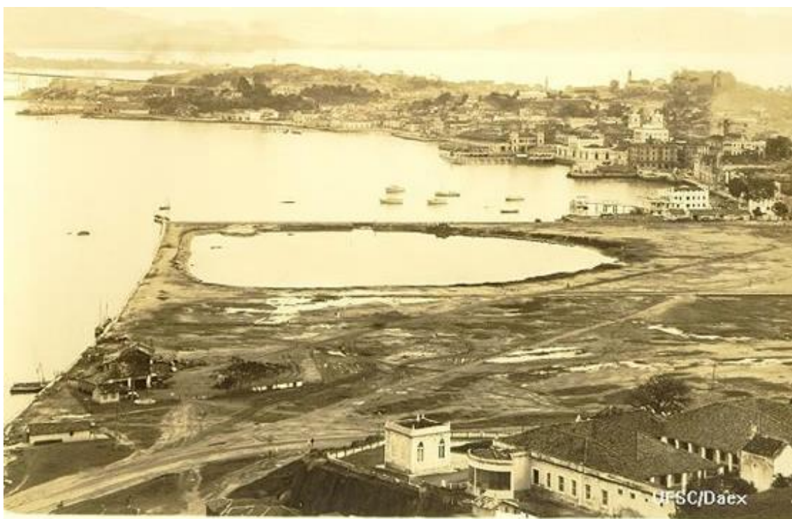
Figura 28. Largo 13 de maio após a execução do aterro na baía. UFSC/Daex.
