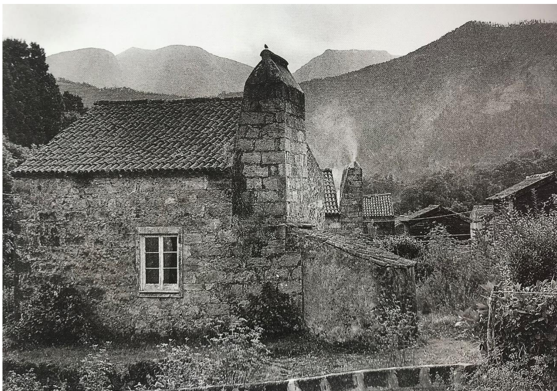
Figura 24. Casa de empena-fachada. Sete Cidades, São Miguel Ocidental (levantamento arquitetônico Anexo 7)
