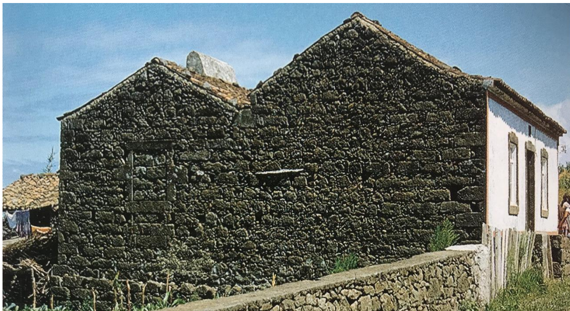
Figura 20. Casa integrada, com dois telhados. Achada, São Miguel Oriente (levantamento arquitetônico Anexo 4)
