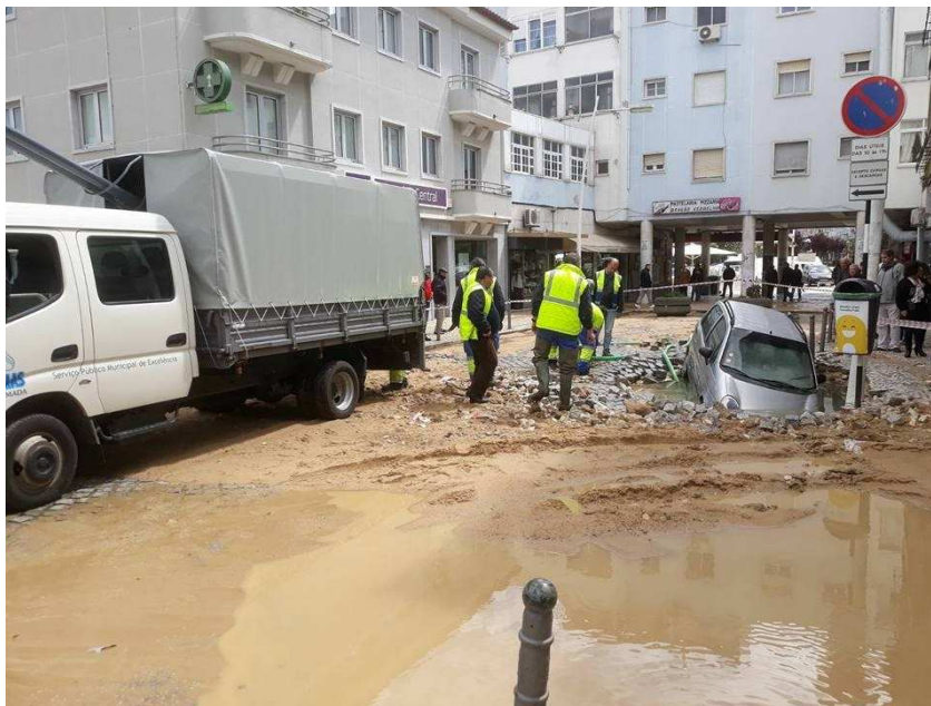
Figura 13 — Rebentamento de uma conduta de água
