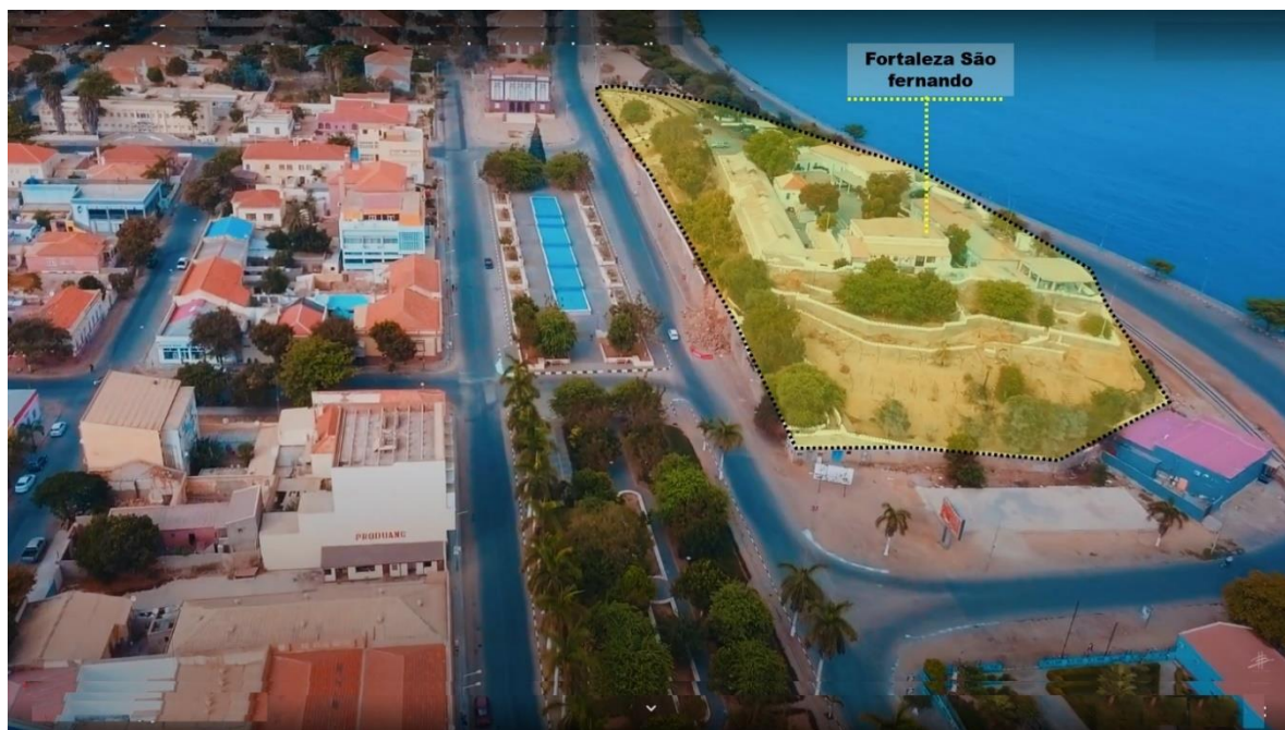
Figura 47 - Fotografia aérea da Fortaleza São Fernando
