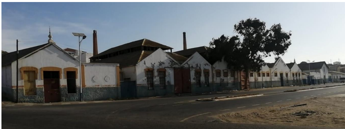
Figura 62 - fotografia das edificações anexas ao Porto Comercial do Namibe.
