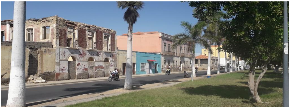
Figura 55 - Quarteirão do Banco de Angola – antiga residência do gerente do Banco.
