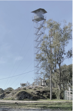
2. Torre de vigia
