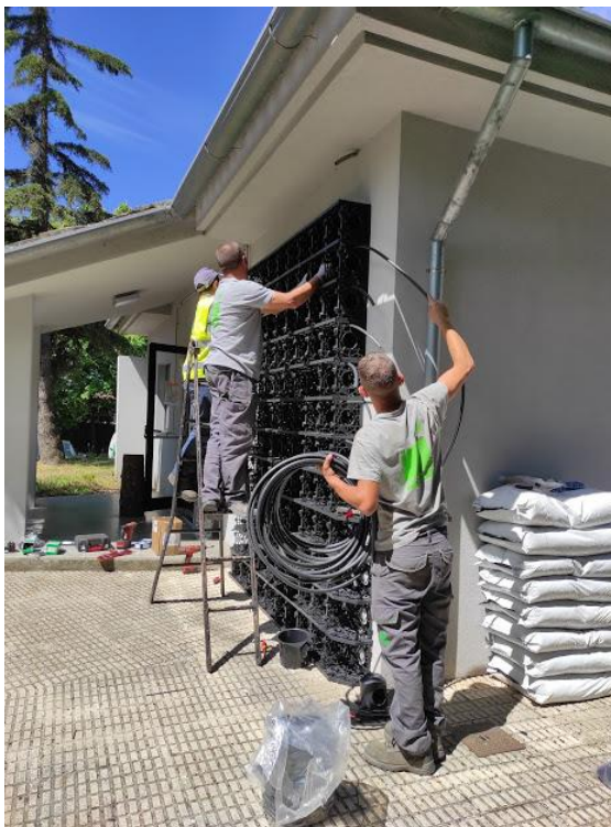
Figura 26 - Colocação dos tubos para o sistema de rega gota-a-gota no dia 8 de maio de 2021
