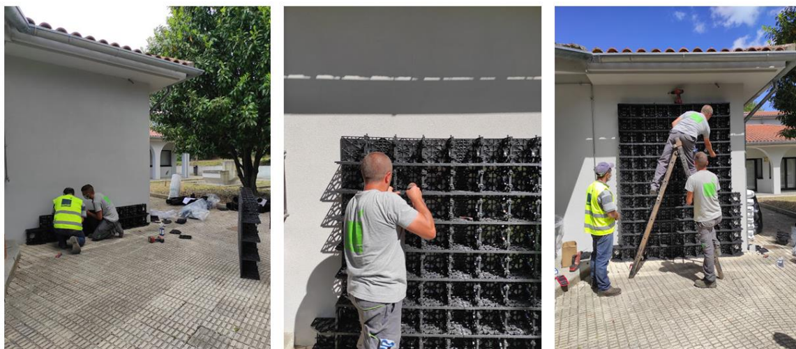
Figura 25 - Instalação da estrutura para a parede verde no Campus Agrário de Vairão, no dia 8 de maio de 2021
