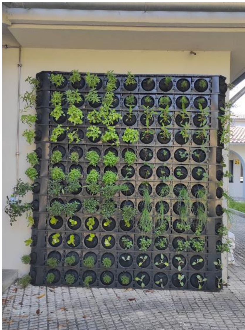
Figura 35 - Parede verde após as plantações e já com todos os módulos colocados na estrutura
