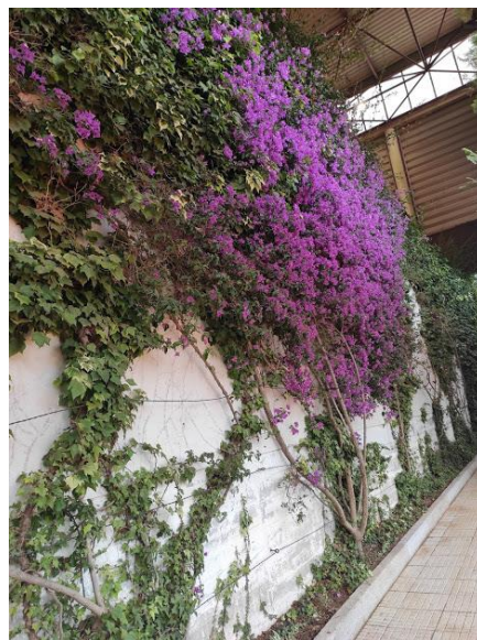
Figura 8 - Fachada verde direta no Complexo Municipal de Ténis da Maia, Portugal (2021)
