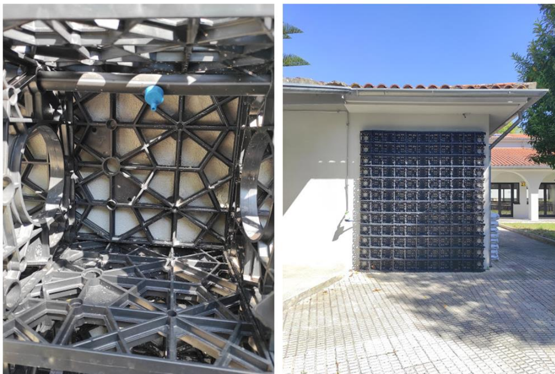
Figura 27 - Resultado final após a montagem completa da estrutura e de colocados os gotejadores para o sistema de rega no dia 20 de maio de 2021
