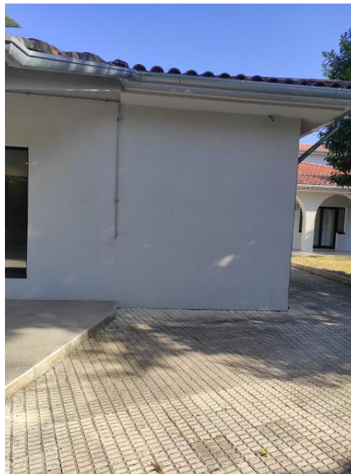
Figura 24 - Parede exterior do Campus Agrário de Vairão onde foi realizado o estudo. Imagem retirada antes da instalação da parede verde no dia 8 de maio de 2021
