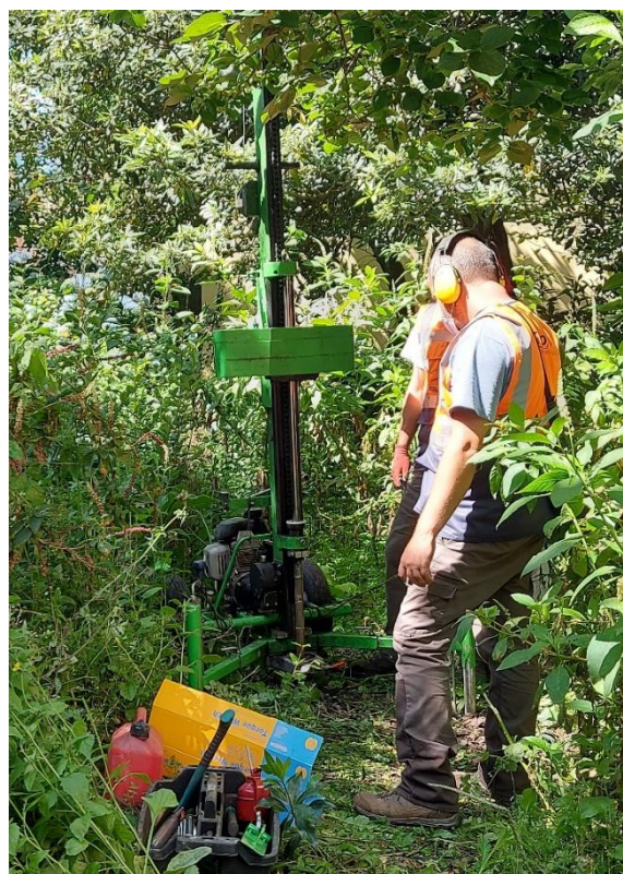
Figura 15 - Equipamento usado no ensaio DPSH.
