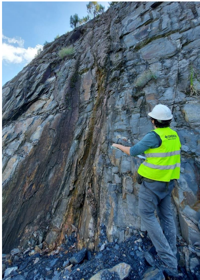
Figura 12 - Falhas com argilização.
