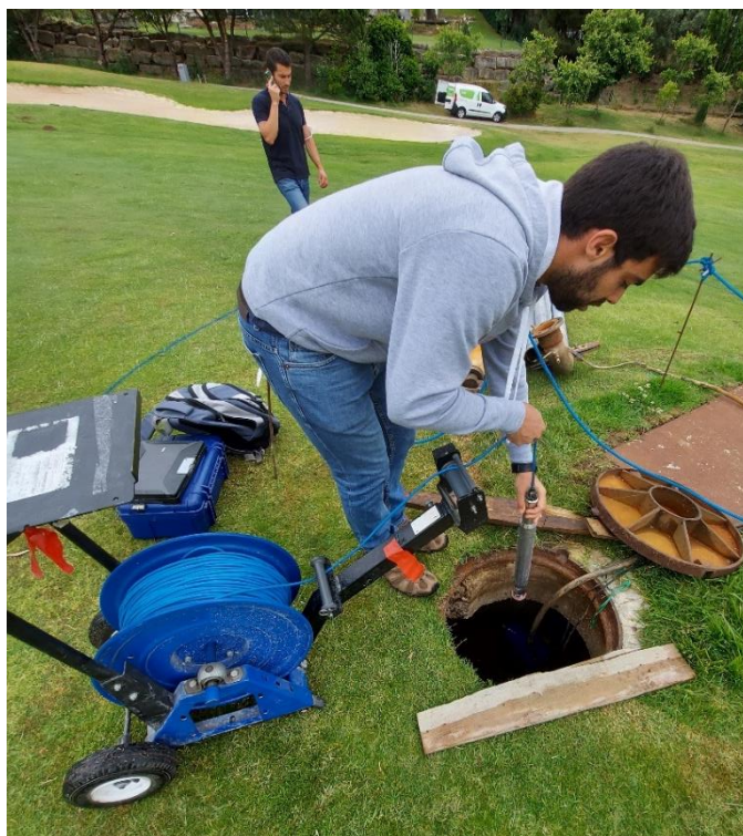
Figura 16 - RCAM 1000 da Laval underground Surveys a ser inserido no furo de captação de água.
