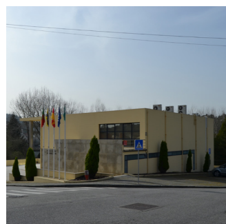
Fig. 8. Edifício da Junta de Freguesia de Pedroso e Seixezelo.
