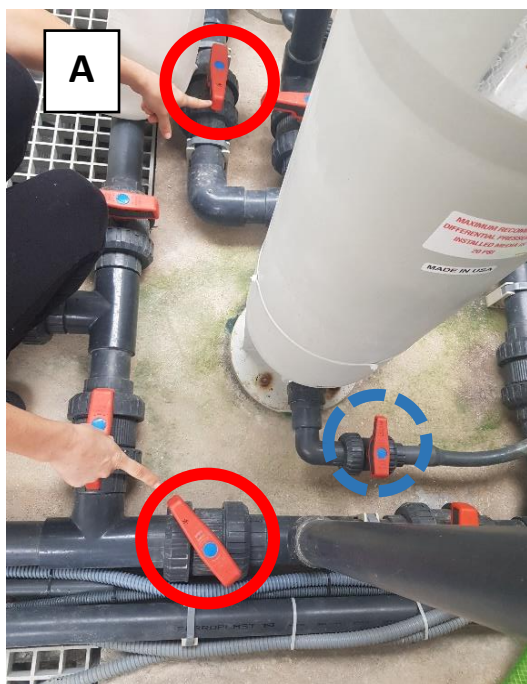
Figure 1 - A - Válvulas do filtro mecânico abertas (válvulas de entrada e saída / círculo recortado - válvula de esgoto fechada) / B - Válvulas do filtro mecânico (fechadas) e válvula de esgoto (aberta) durante o procedimento.
