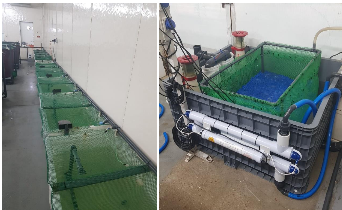
Figura 17 - Tanques de aclimação e respetiva sump.
