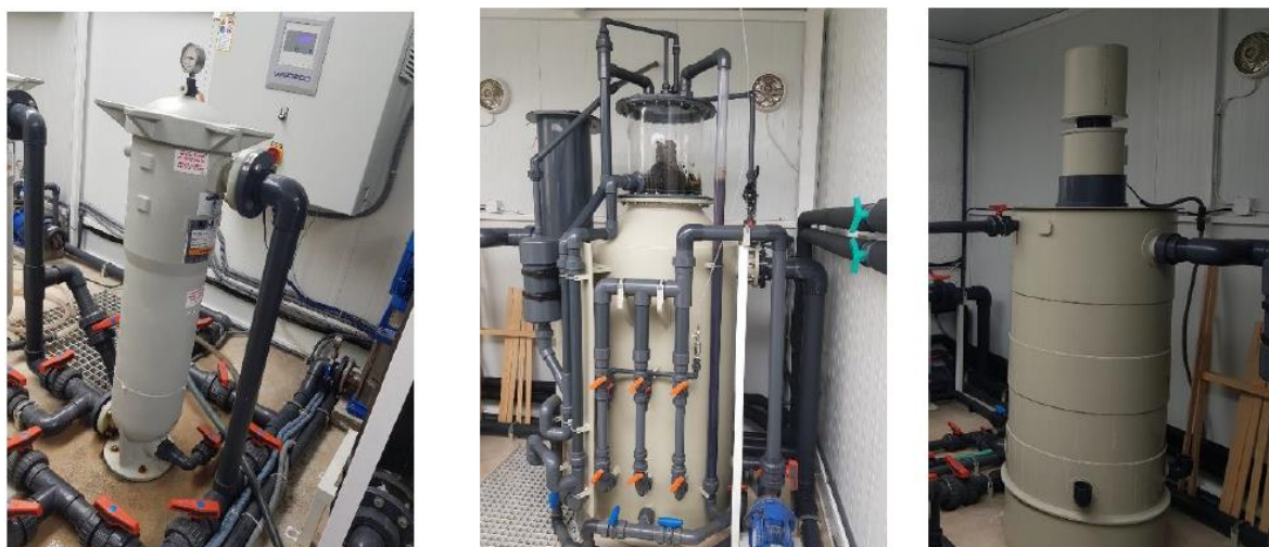
Figura 14 - Filtro mecânico, escumador e filtro biológico.
