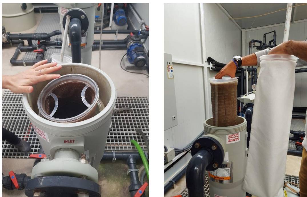
Figura 3 - Manga do filtro mecânico utilizada e limpa.
